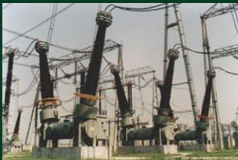
落地罐式SF 6 断路器
