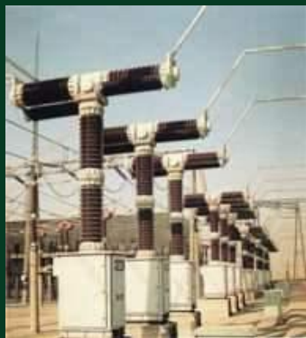
瓷柱式SF 6 断路器
