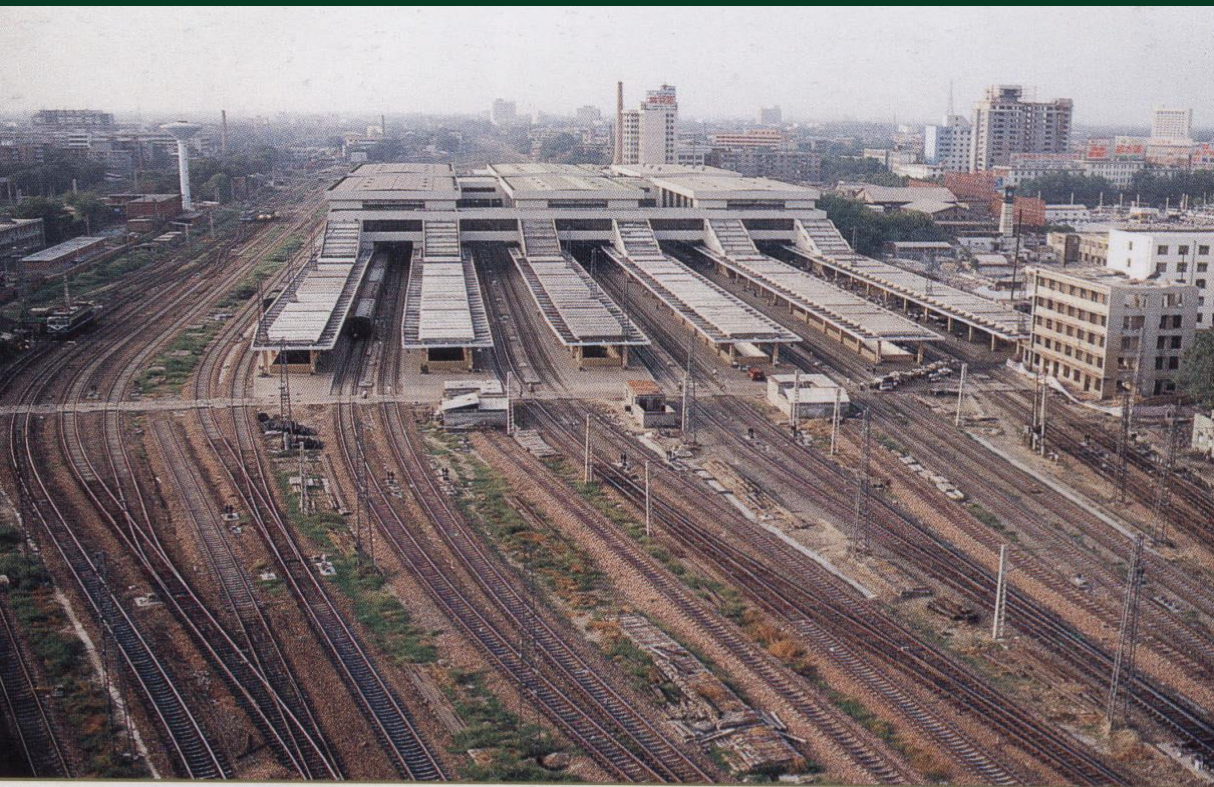
郑州站高架候车室，建筑面积 2 万平方米， 6 个候车大厅，可容纳 1.5 万名旅客同时候车
