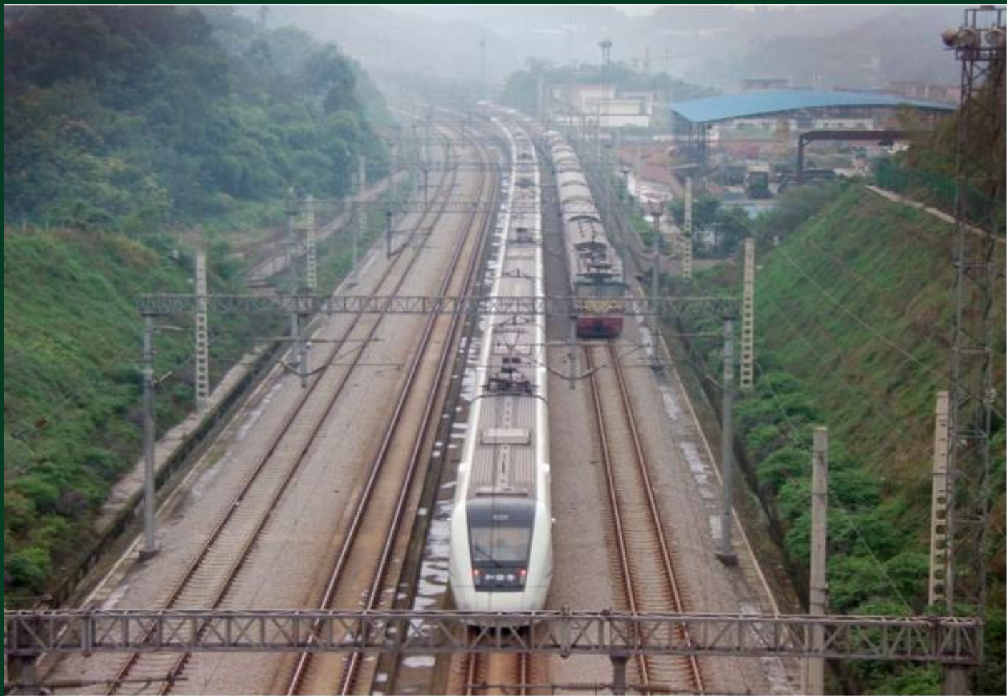
无砟轨道上的中间站
