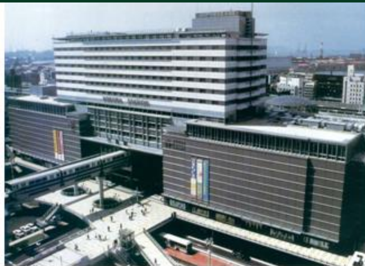
图 9-1 日本山阳新干线小仓新车站
