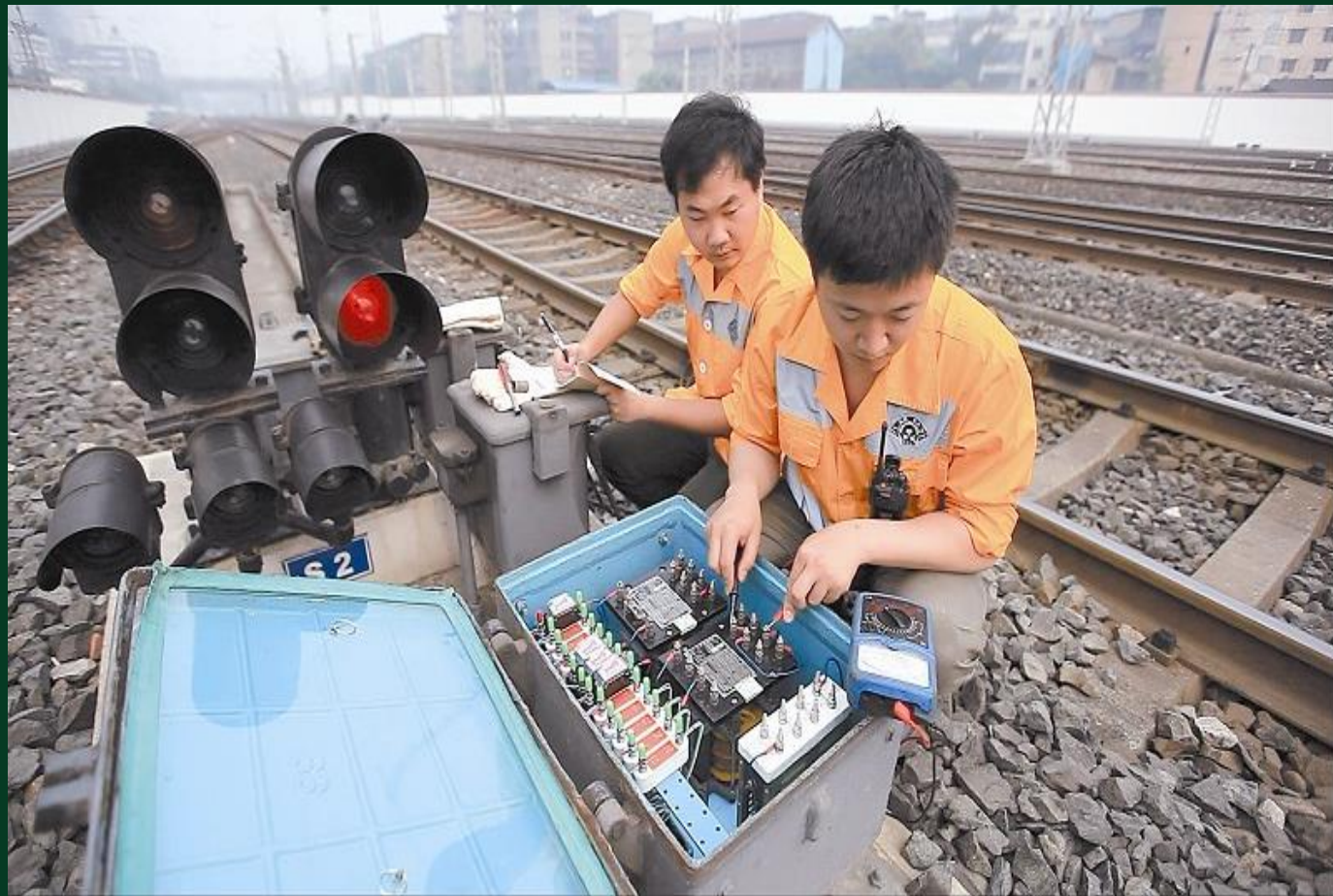
铁路一线:成都电务段强化汛期设备检查
