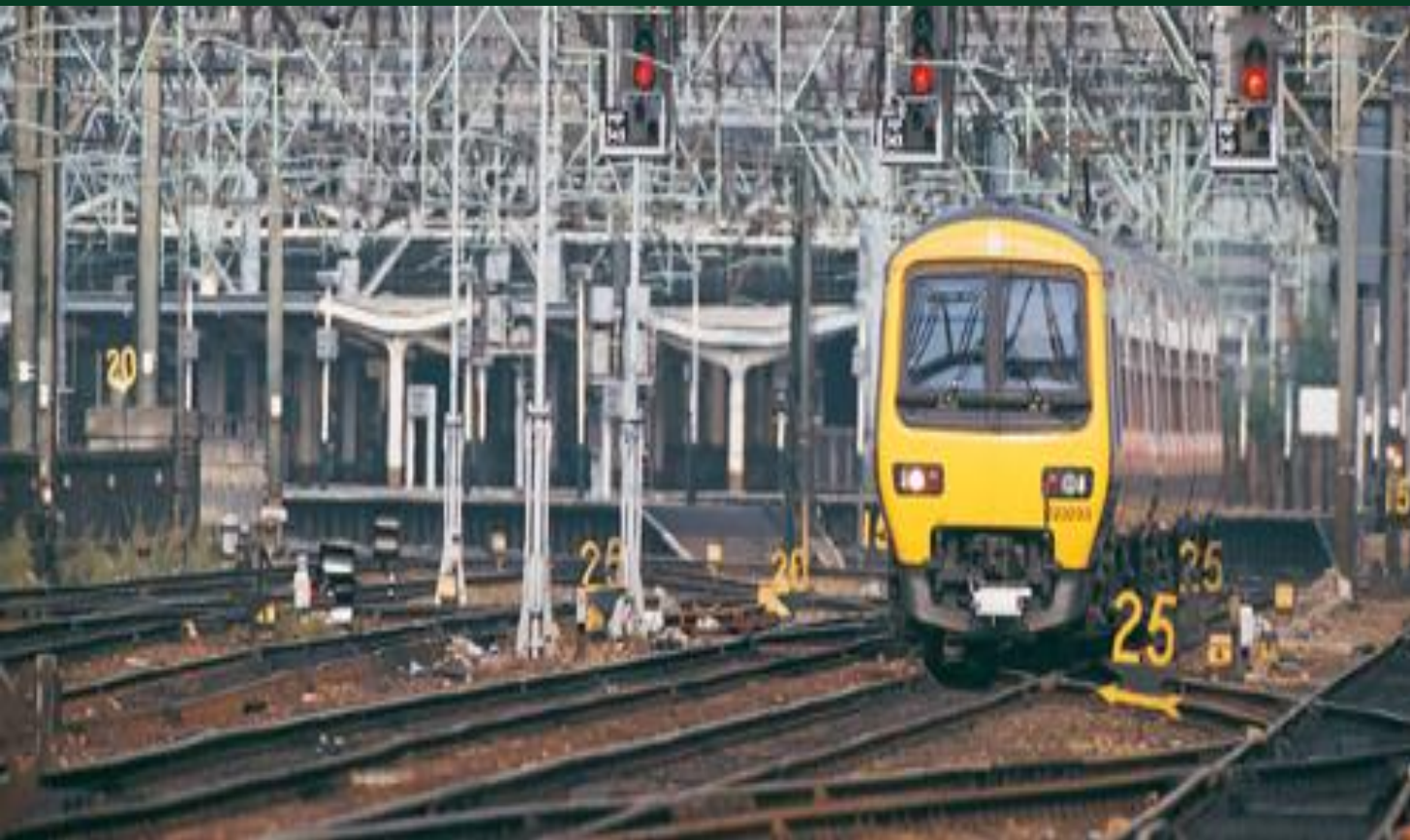
铁路信号微机监测系统
