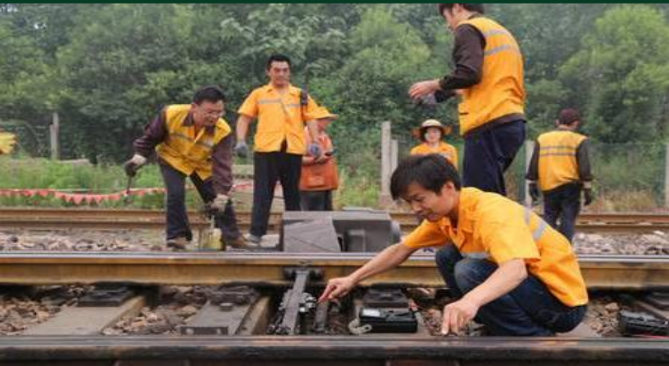
洛阳电务段作好 夏季轨道电路检 测养护
