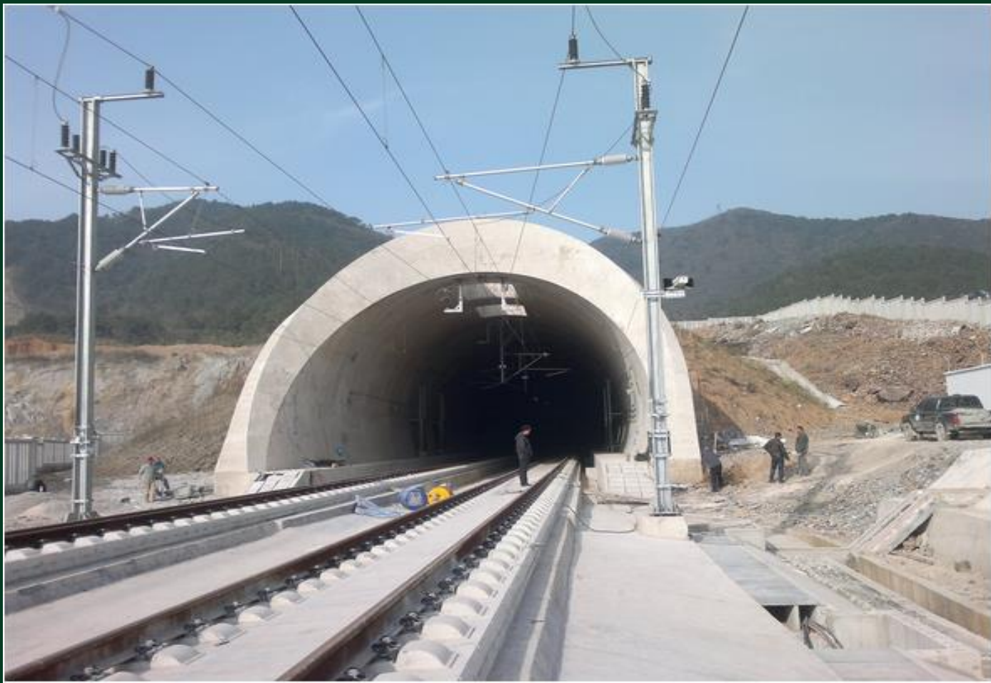
京沪高速铁路工程
