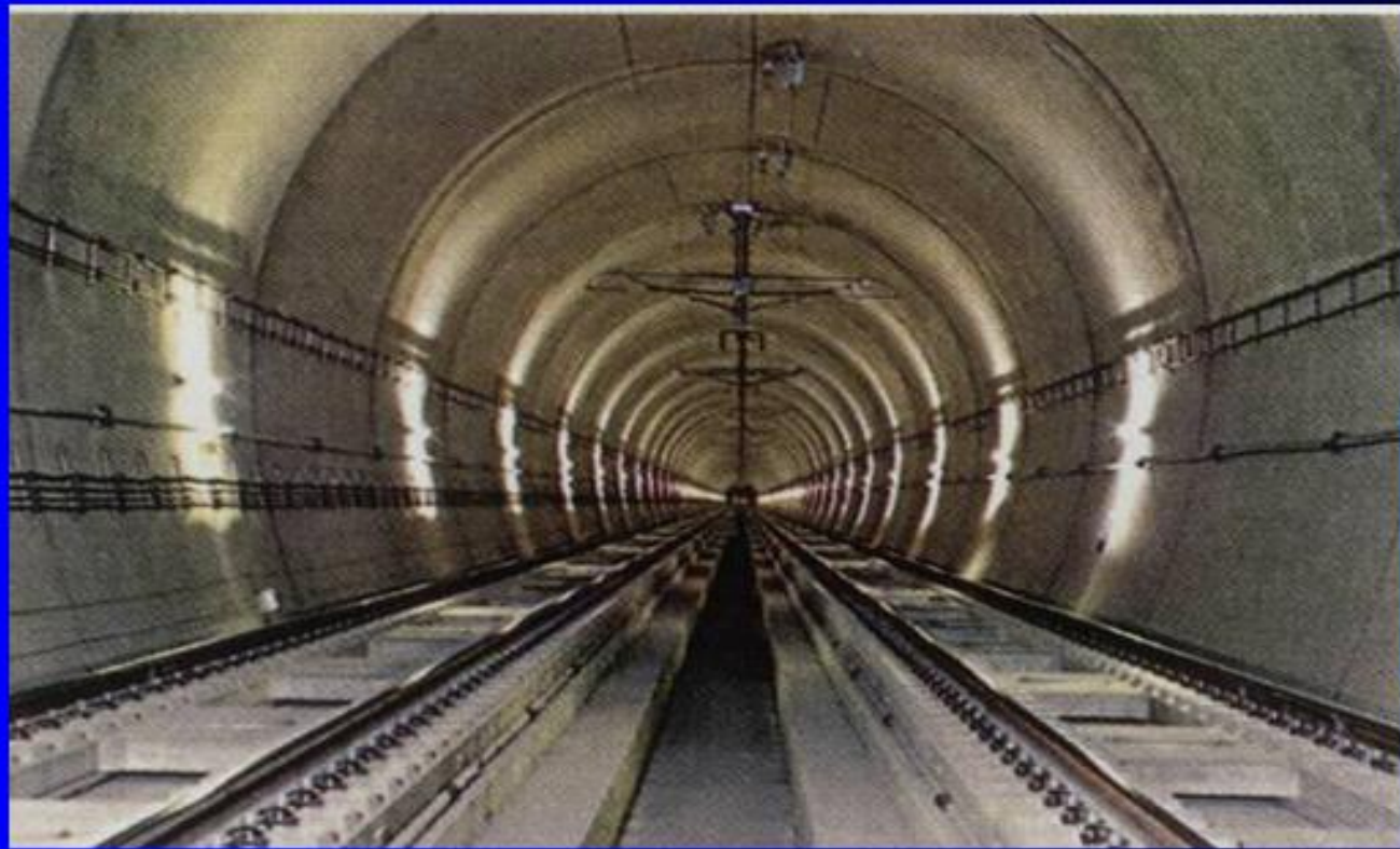
日本岩手一户隧道
