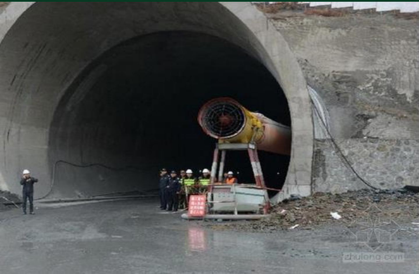
吉林吉琿高铁在建隧道
