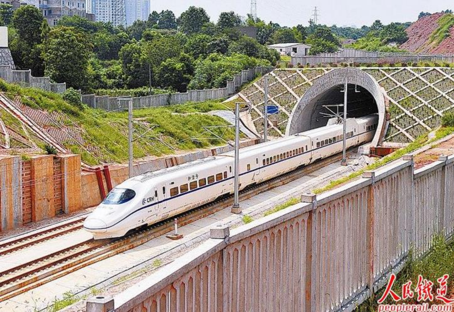
京沪高速铁路工程
