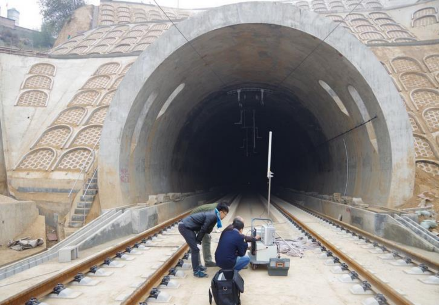
大西高铁隧道口进行测量
