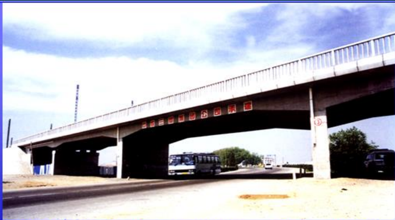
秦沈客运专线杨士岗大桥， (16+2\times 24+16) m 钢筋混凝土刚构连续梁桥。
