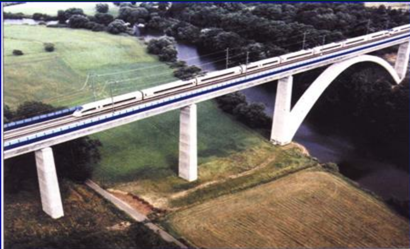
Abb. 1: Neubaustrecke Köln - Rhein/Main, Lahntalbrücke
