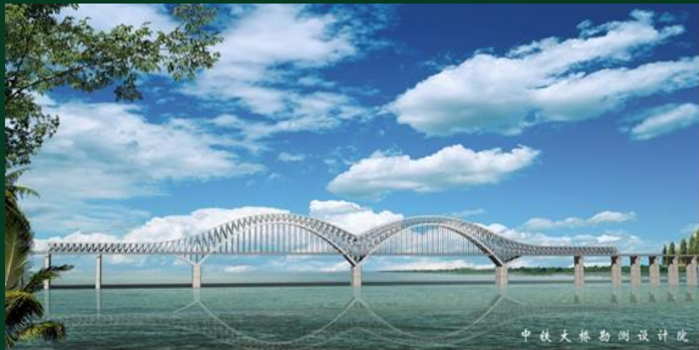
图 5-18 京沪高速铁路上的南京长江大桥的主跨 336m 的钢桁梁桥设计方案
