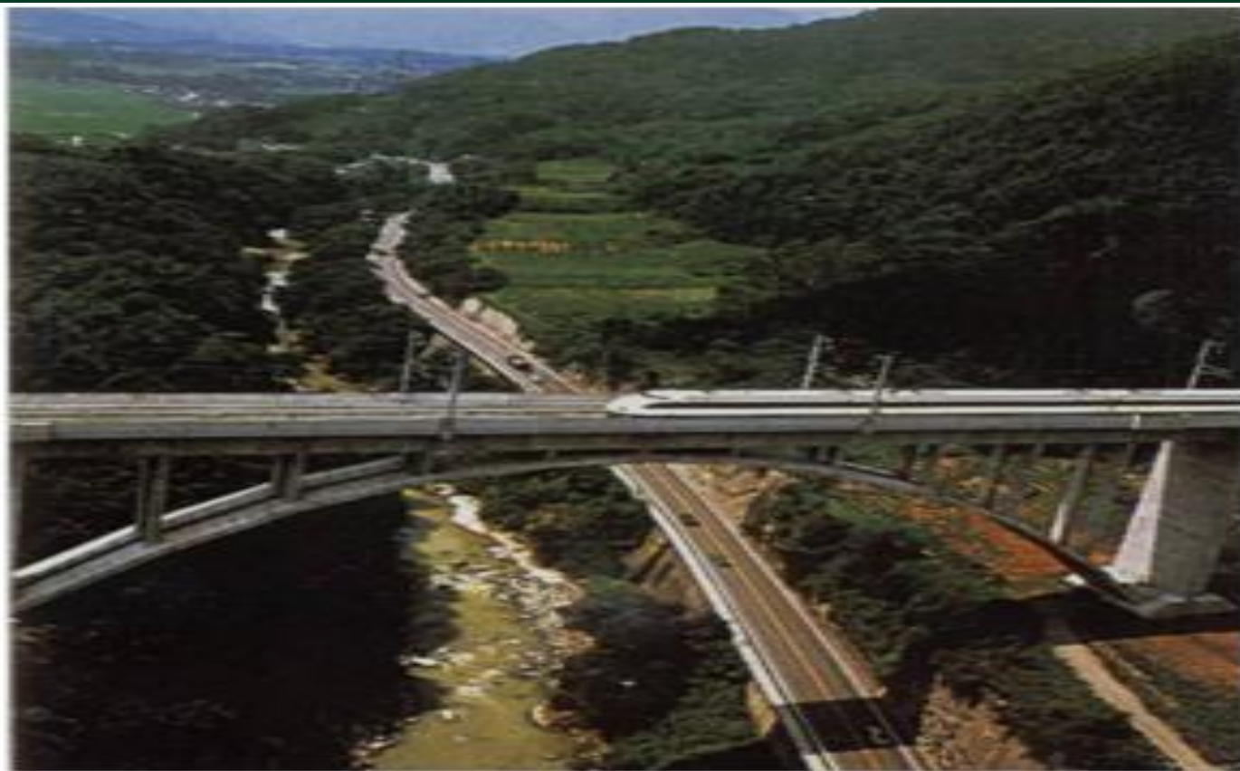
日本上越新干线赤谷川桥
