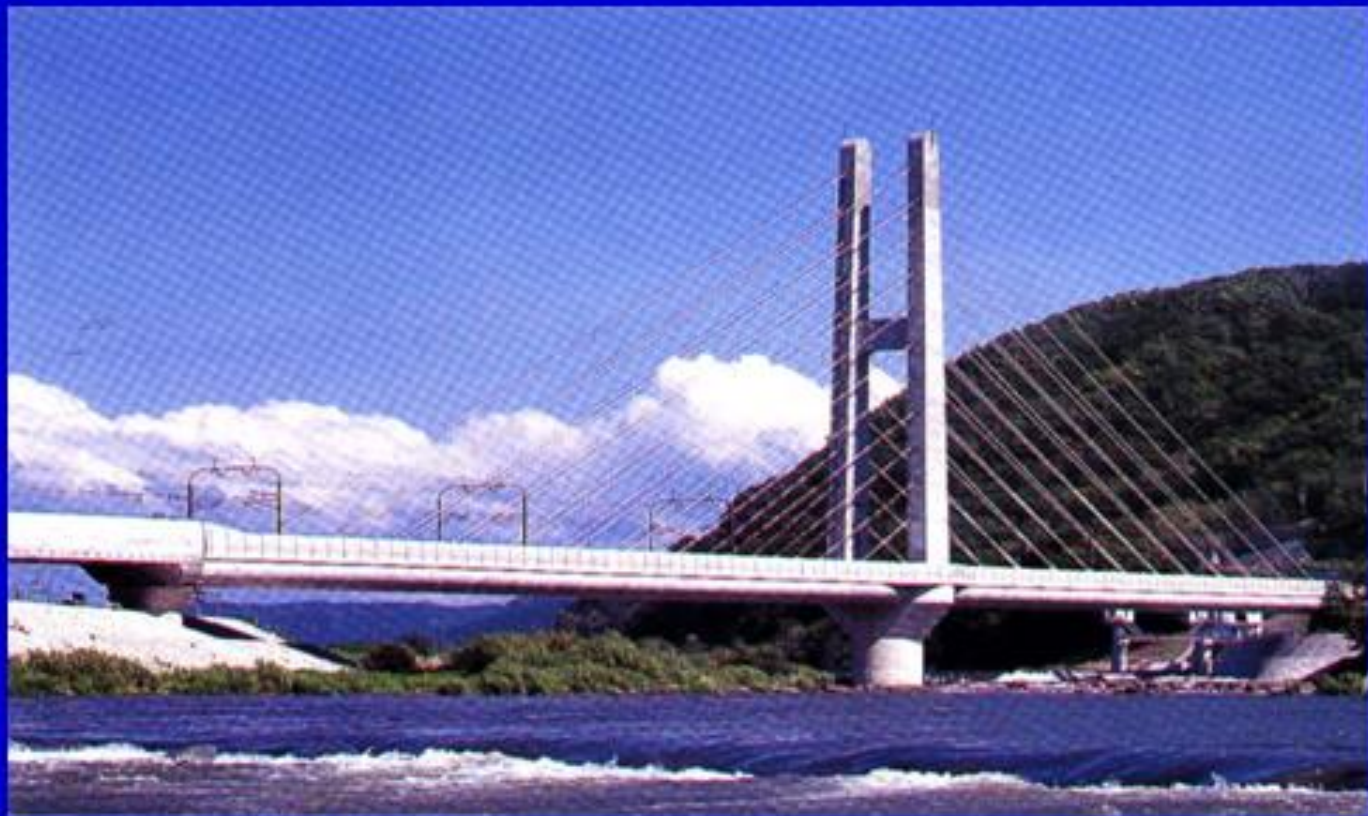
日本 第二千曲川桥 133.9+133.9m预应力混凝土斜拉桥
