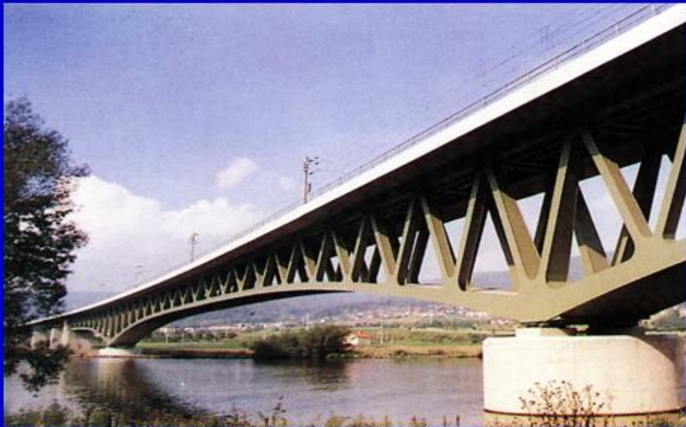
德国 纳登巴赫 美因河桥 (83.2+208+83.2m) 顶底板钢-混结合桁架桥
