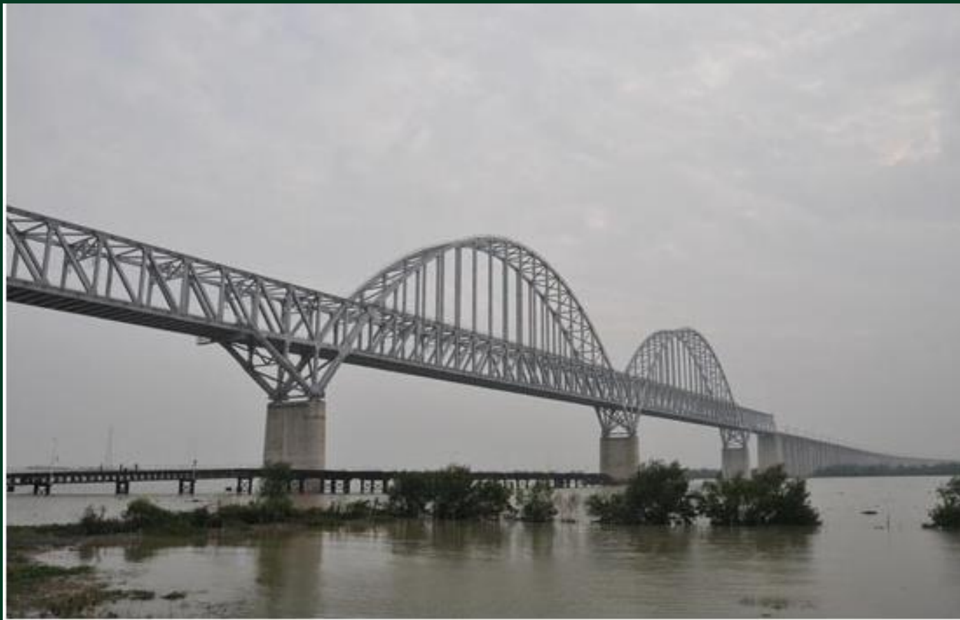
厦深铁路重难点工程榕江特大桥
