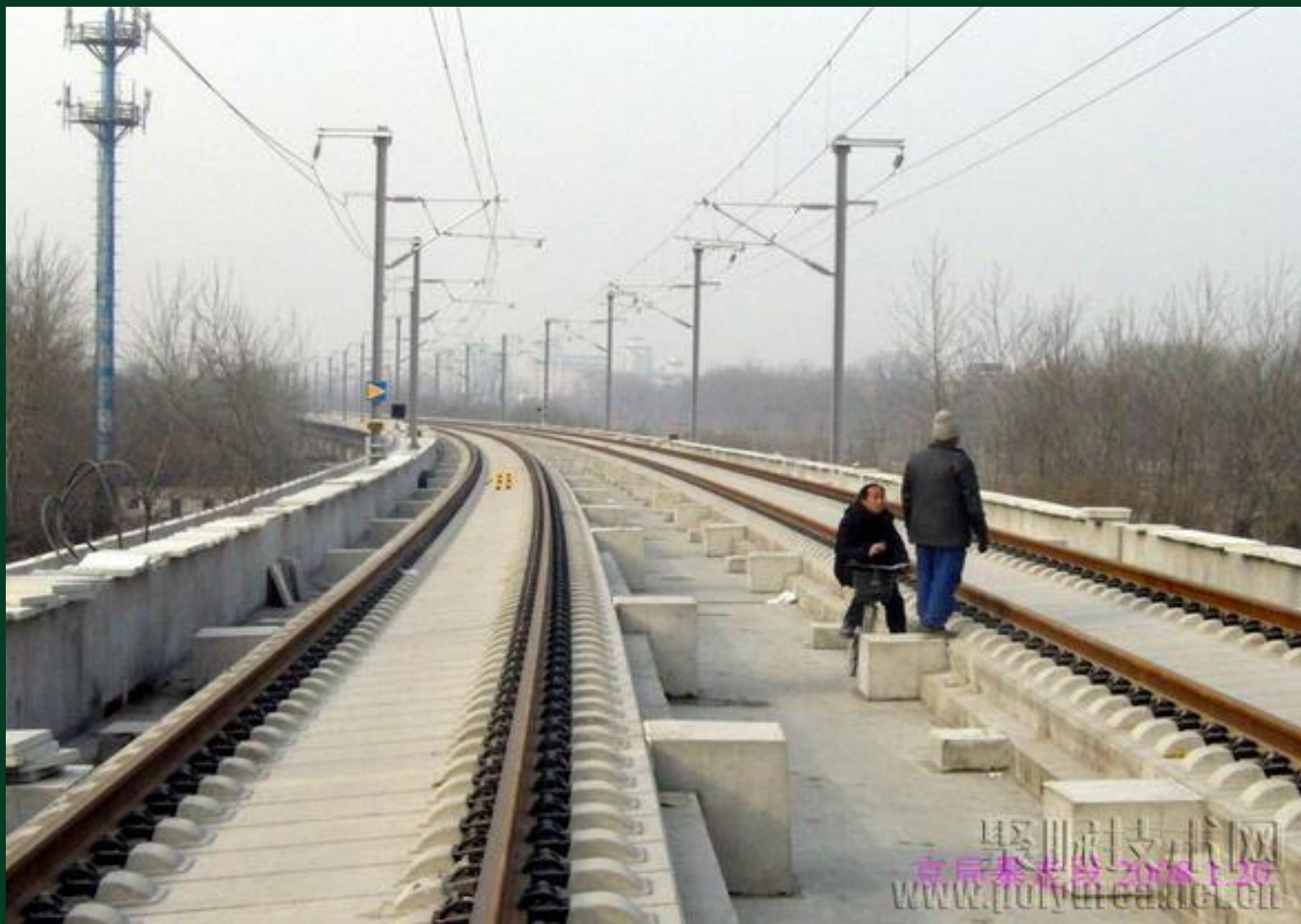
京沪高速铁路桥梁桥面布置
