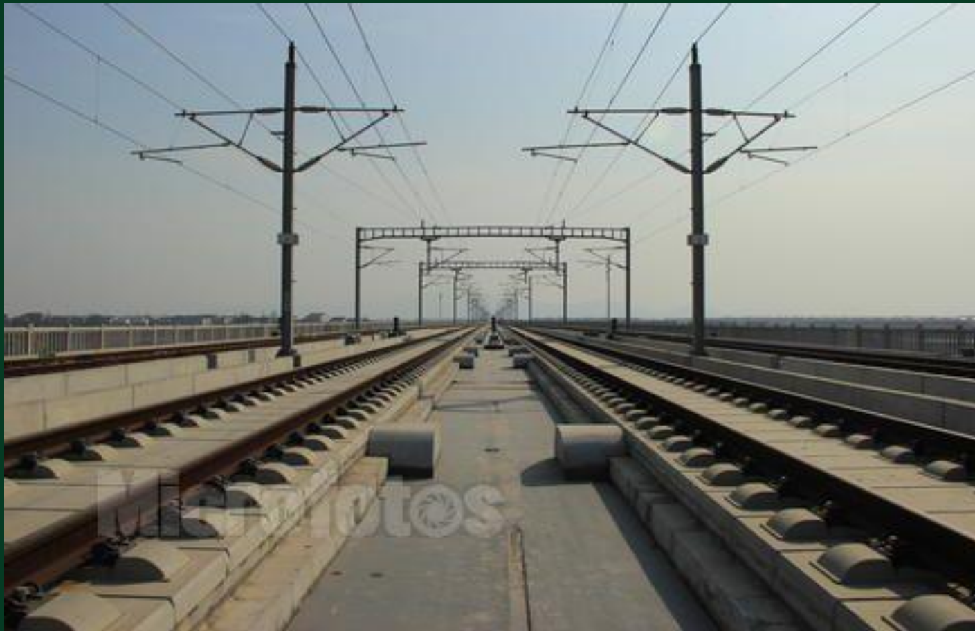
高速铁路桥梁桥面布置
