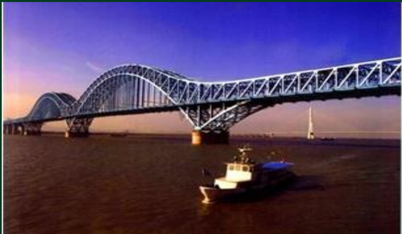
京沪高速铁路南京大胜关长江大桥
