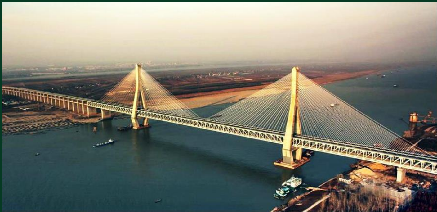
武广高铁武汉天兴洲大桥
