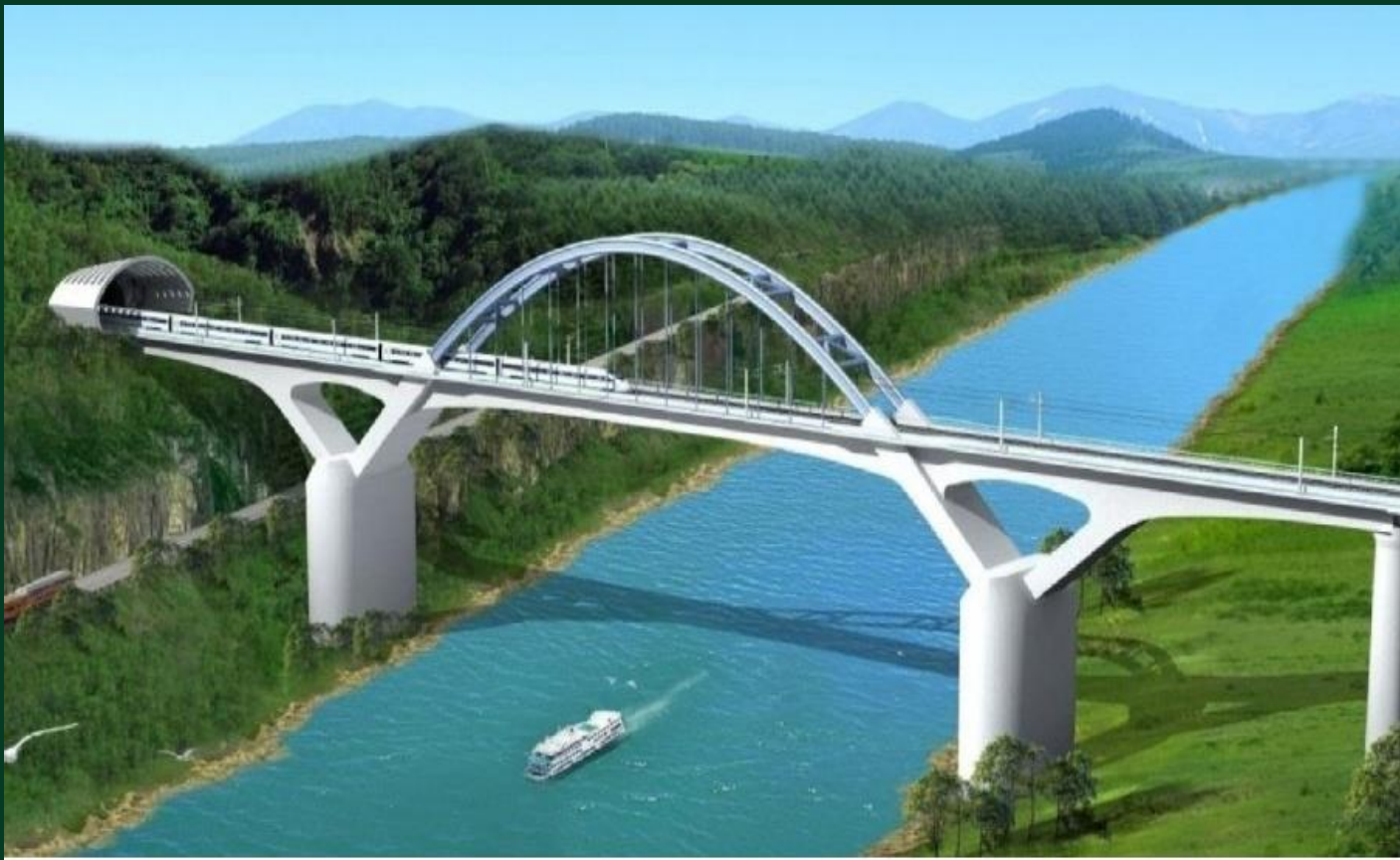
成渝高速铁路客运专线工程
