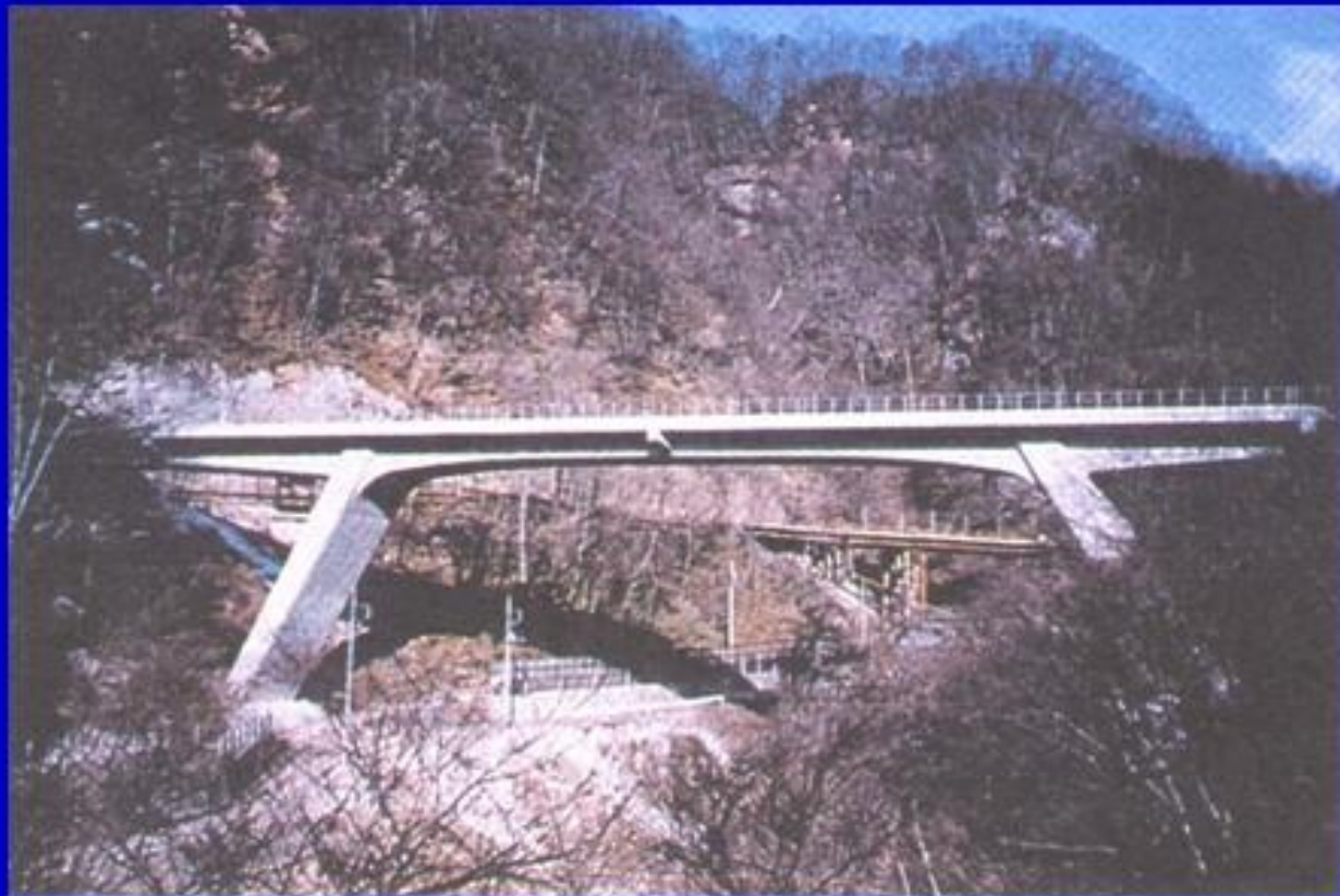
日本 雾积川桥 26.3+51+31.5m预应力混凝土斜腿刚架
