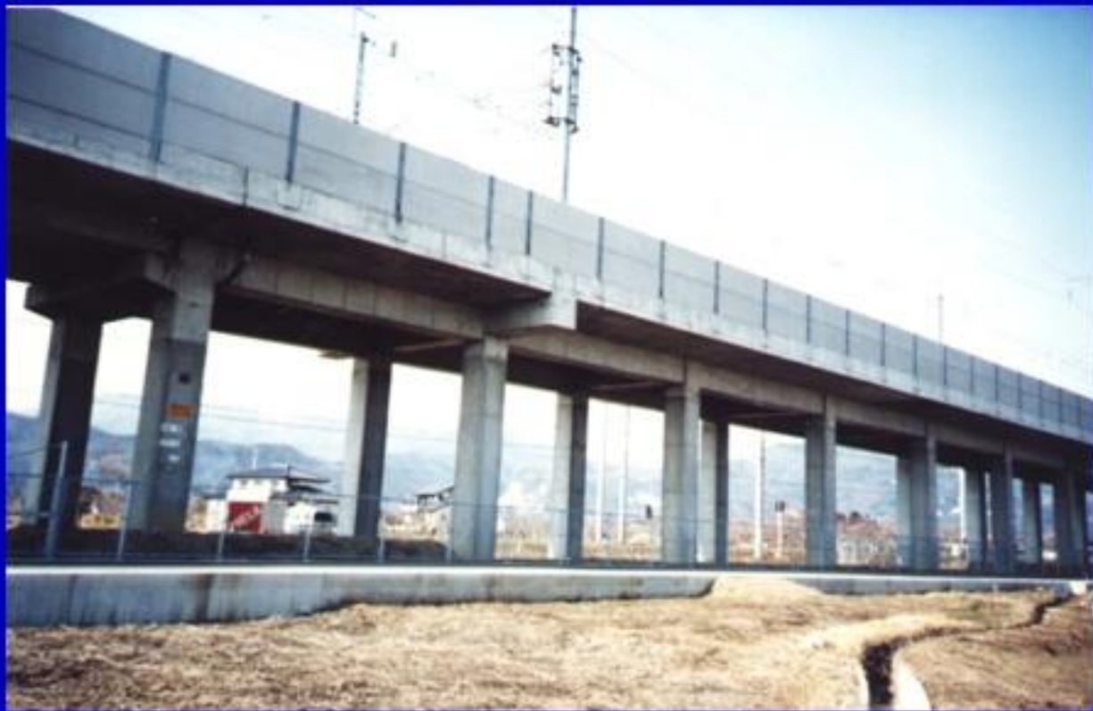
日本 钢筋混凝土连续刚架高架桥
