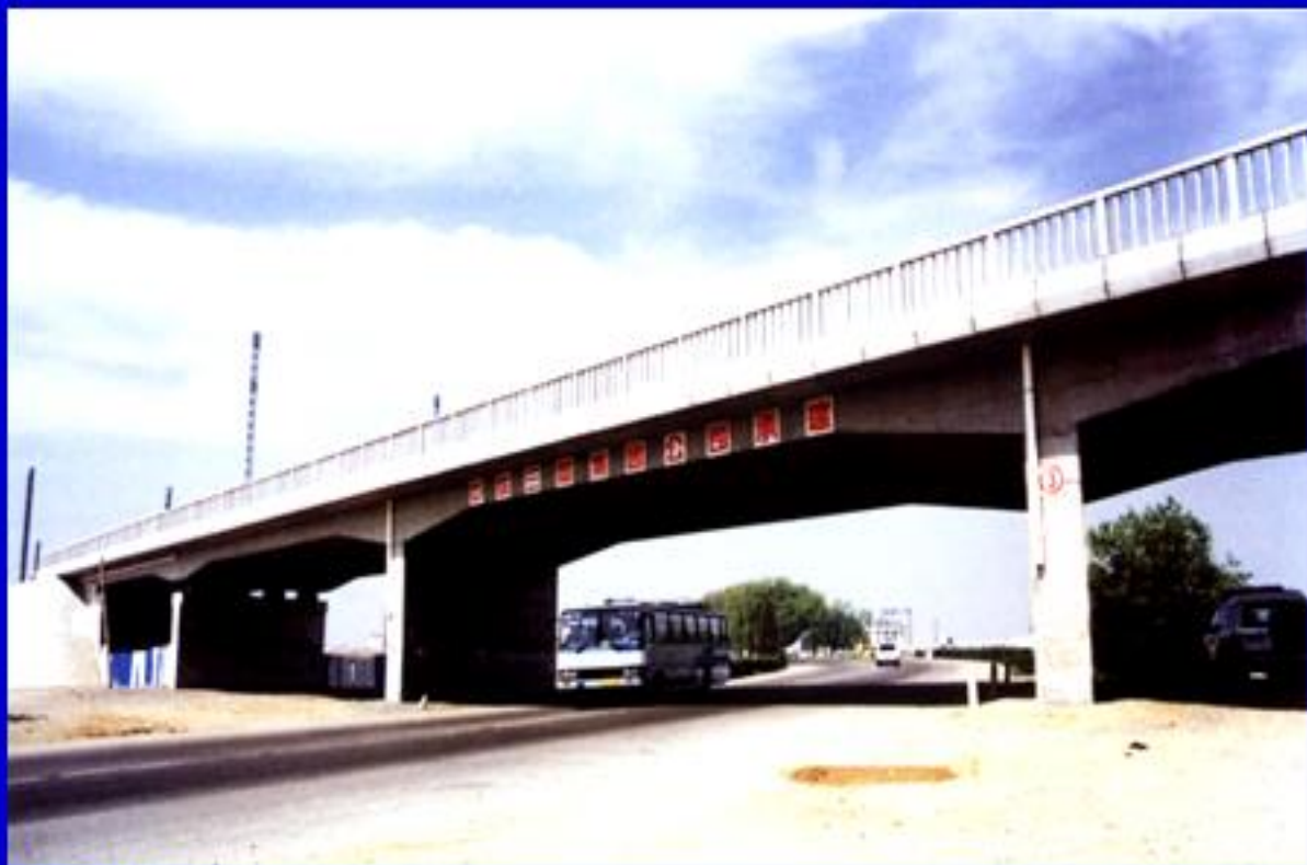
秦沈客运专线杨士岗大桥， (16+2\times 24+16) m 钢筋混凝土刚构连续梁桥。
