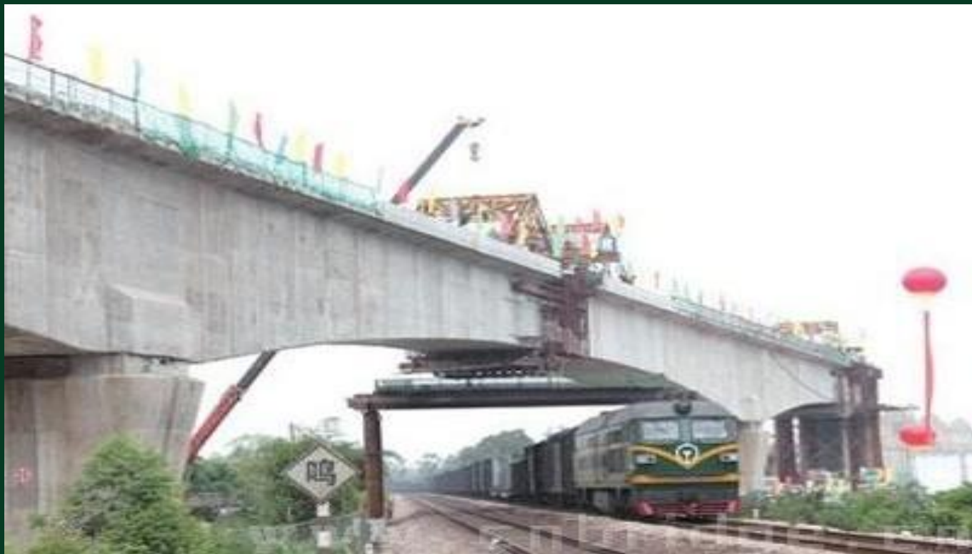
广西高铁首例特大桥转体成功 4200吨巨梁 空中挪动
