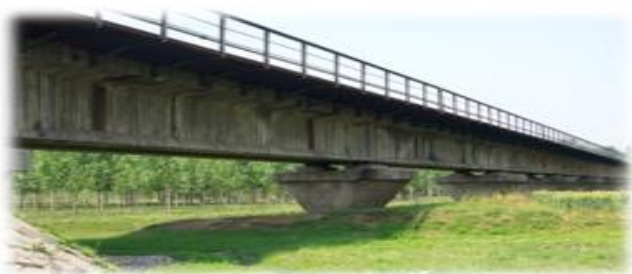
• 普通铁路概貌
