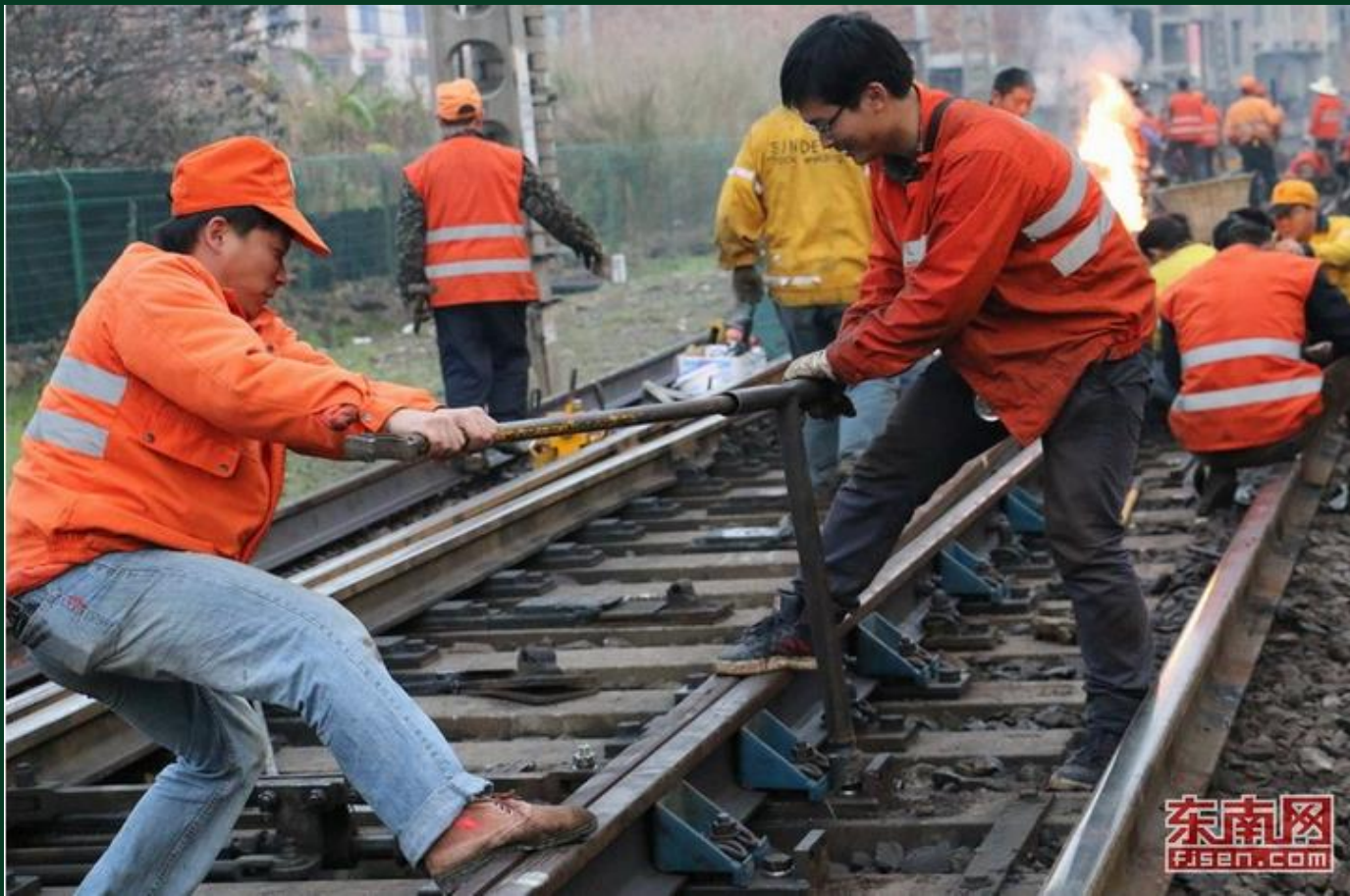
铁路首次进行道岔无缝化焊联施工改造
