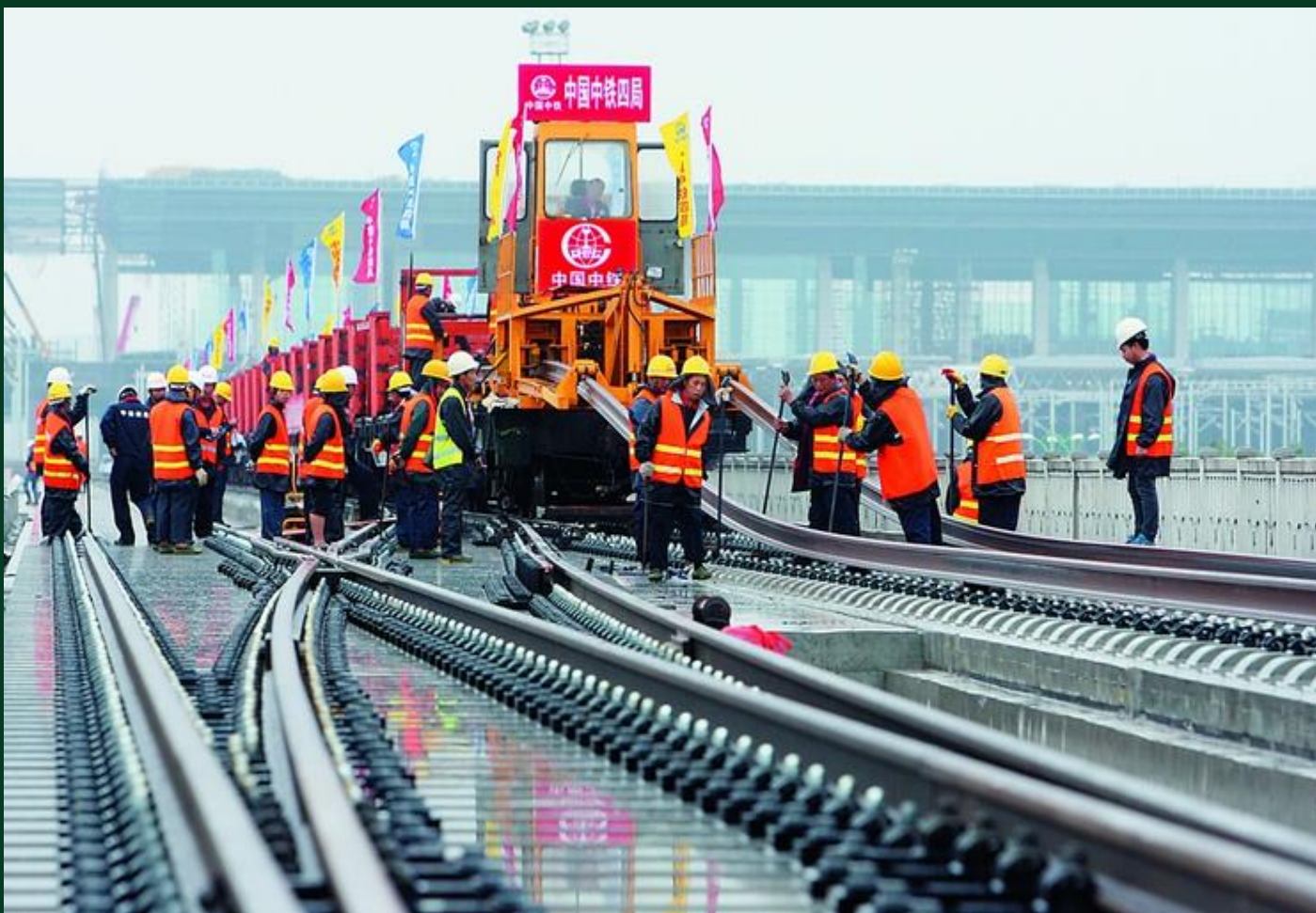
无缝道岔施工
