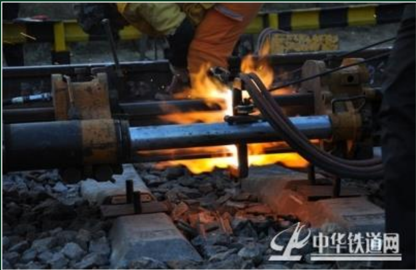
无缝线路焊接
