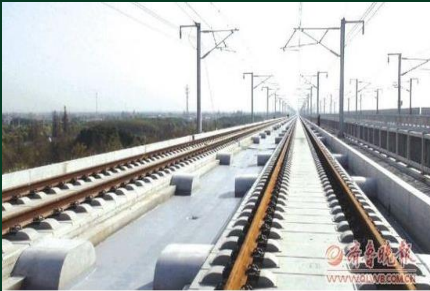
跨区间无缝线路
