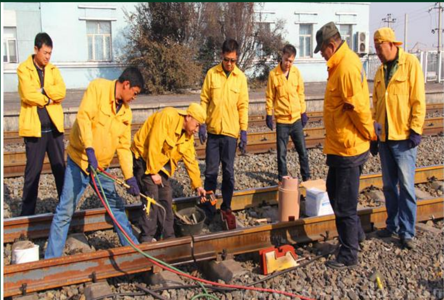
无缝线路焊接
