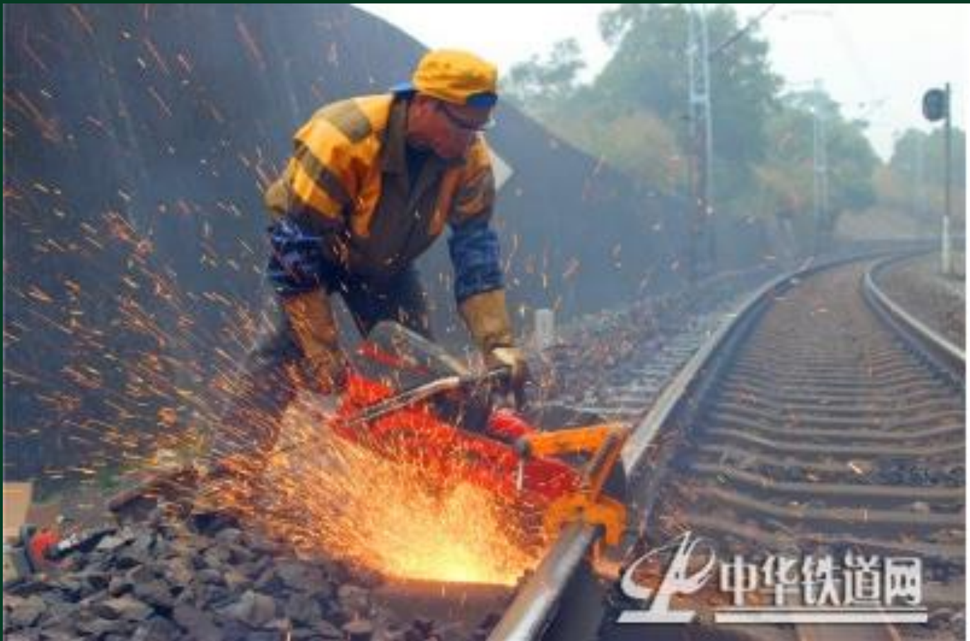
无缝线路打磨
