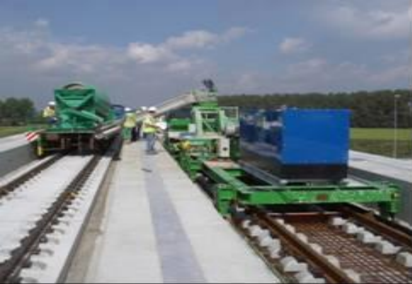
浇筑混凝土板
