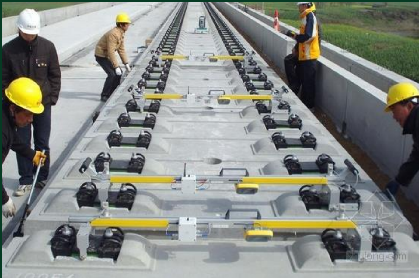
高速铁路II型板式精调
