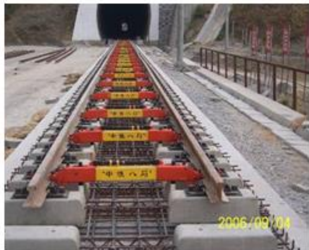
• 双块式无砟轨道施工
