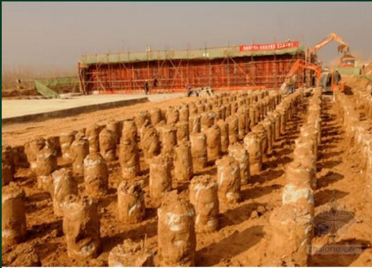
大西高铁CFG开挖现场
