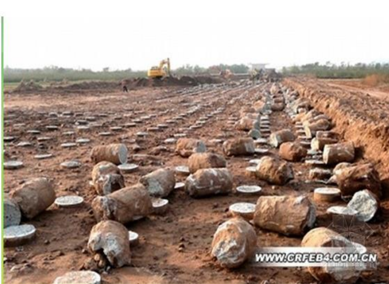
CFG桩头破坏
