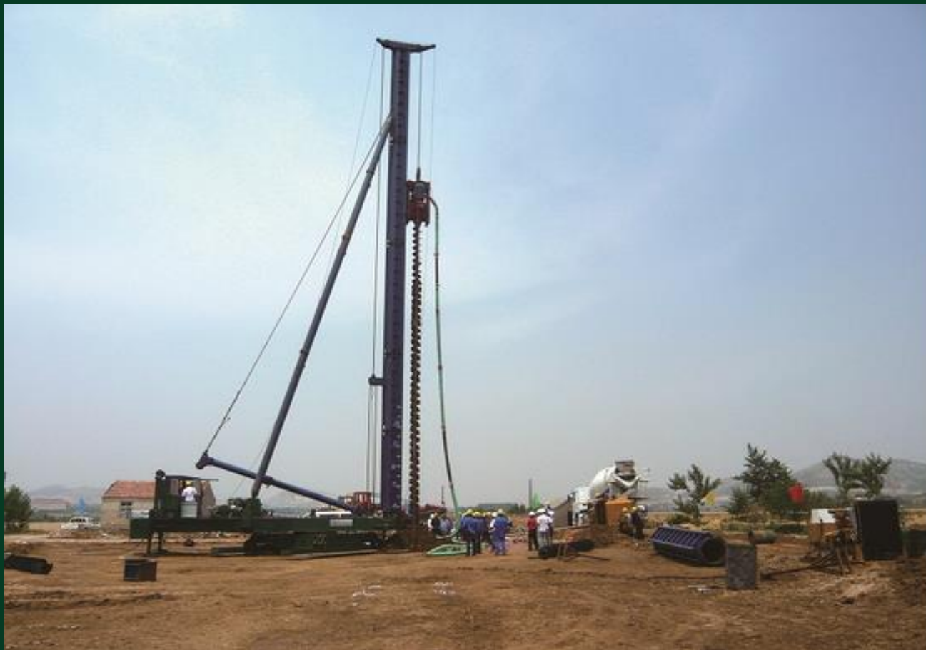
武广高铁CFG桩-水泥搅拌桩
