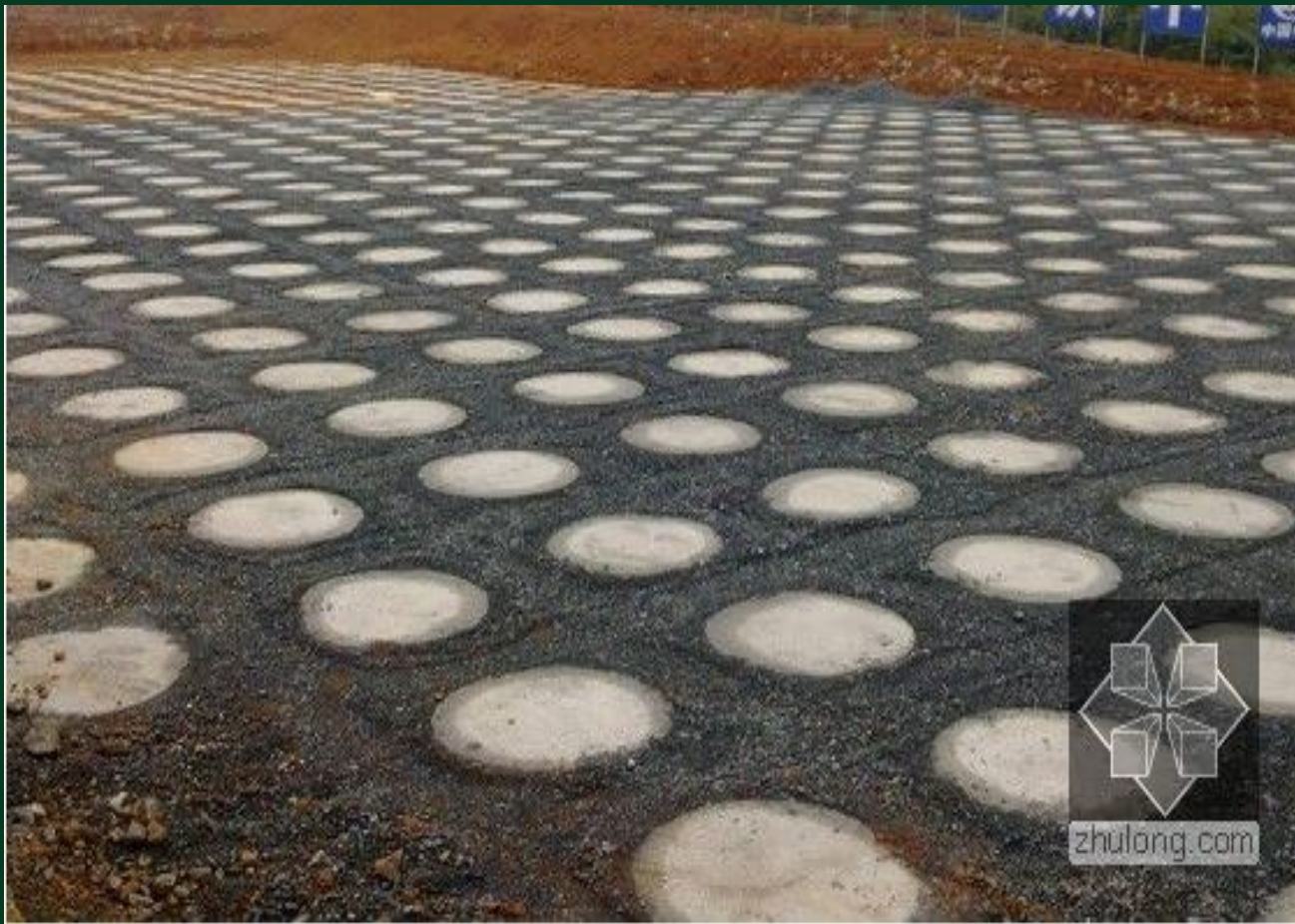
CFG桩帽之间回填
