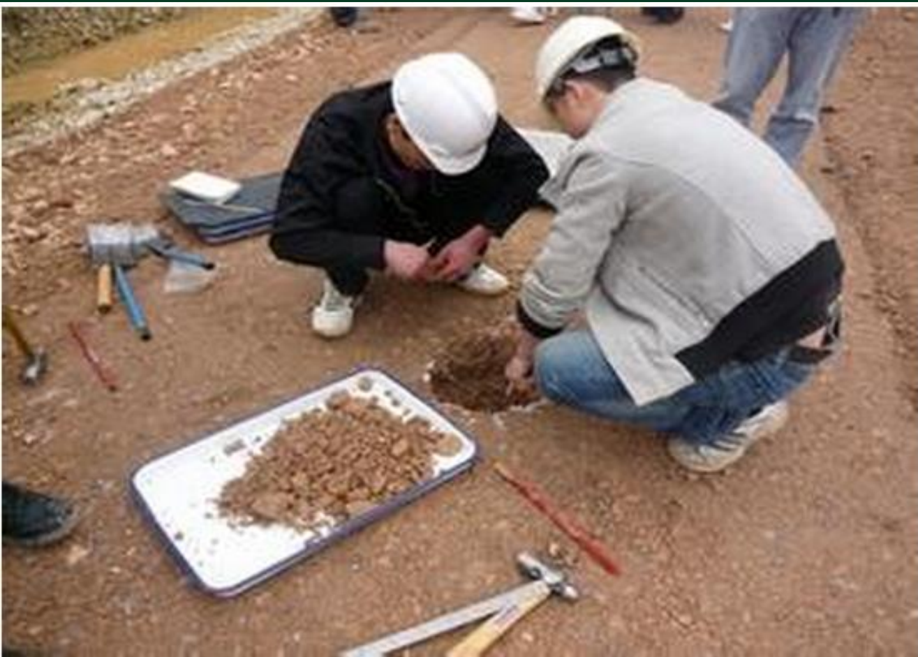
基床底层检测
