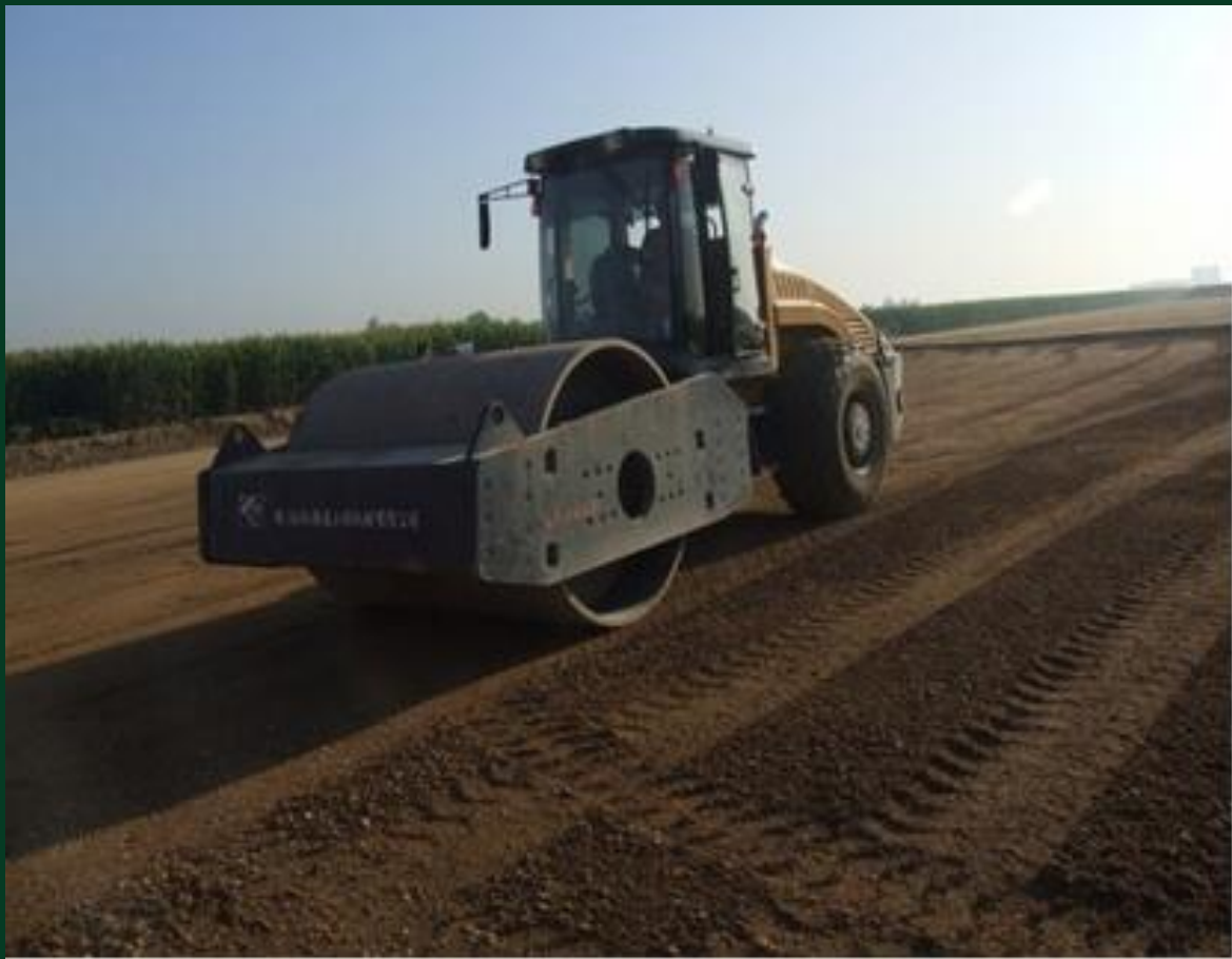
铁路项目基床表层试验段施工现场
