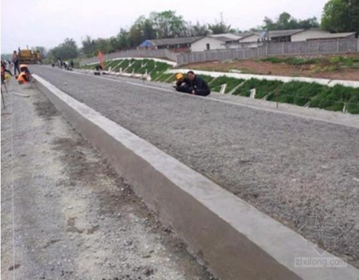
成渝客专率先无砟轨道路基段支承层施工
