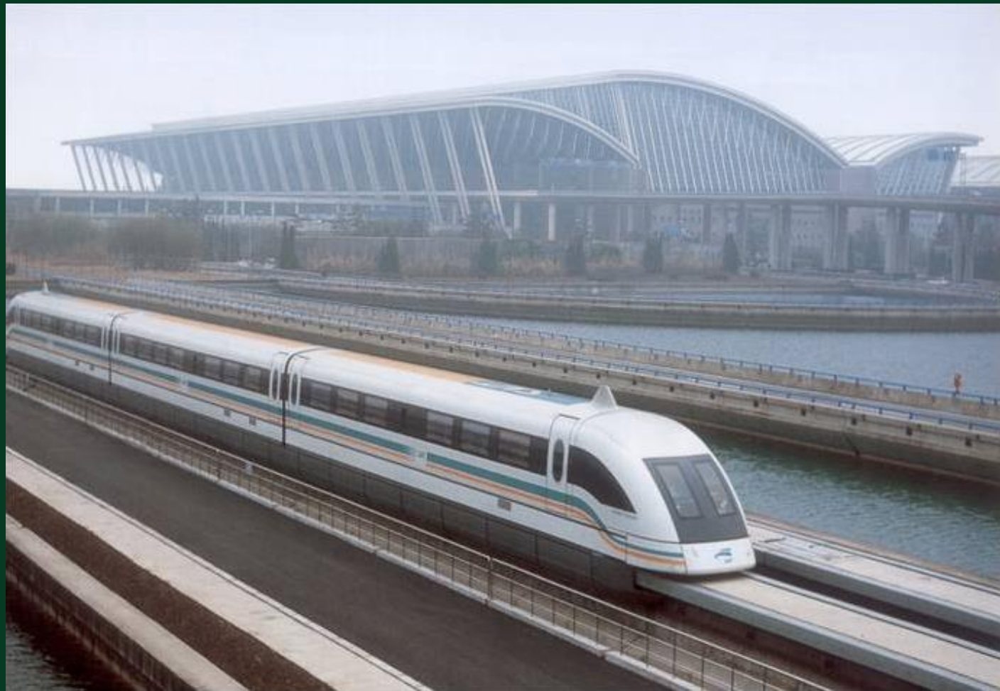
上海磁悬浮列车示范线工程
