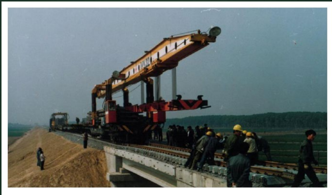
DPK-32型铺轨机
