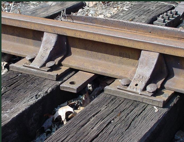
尖轨处基本轨外侧的轨撑
