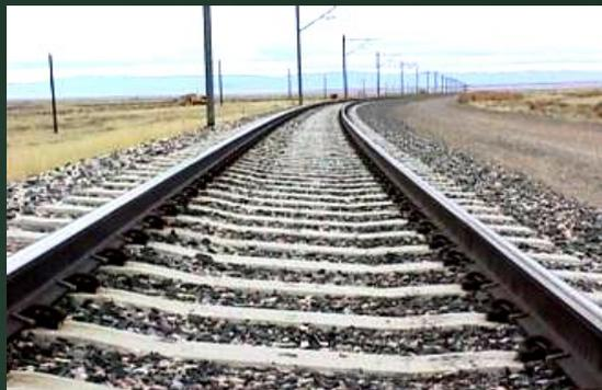
法国TGV高速铁路的双块式混凝土轨枕轨道
