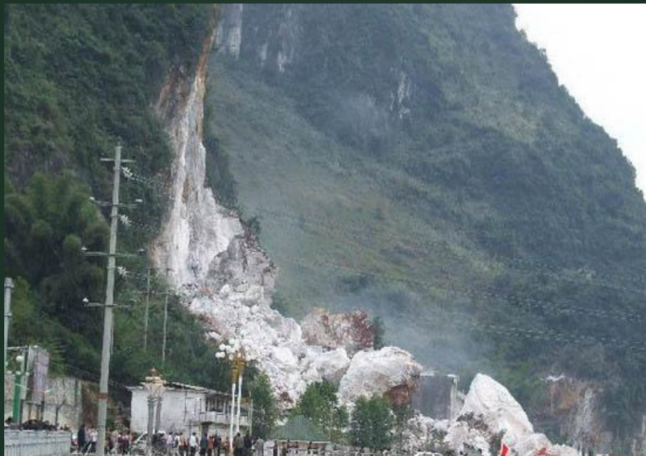
广西风山危岩发生崩塌
