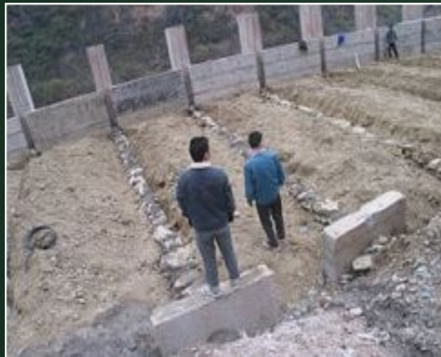
锚定板挡墙（施工中）
