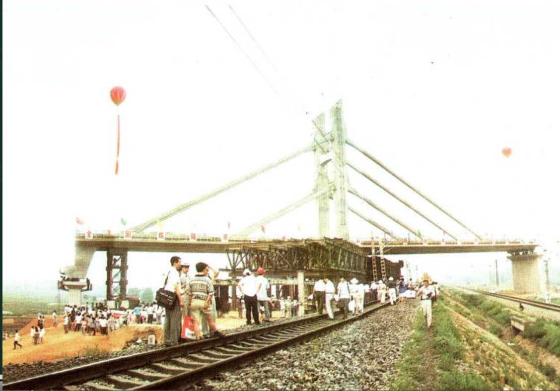
正在转体过程中的大里营铁路斜拉桥
