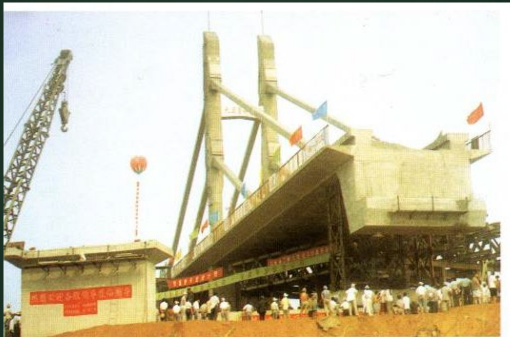
重达3 040t的斜拉桥正在转体施工
