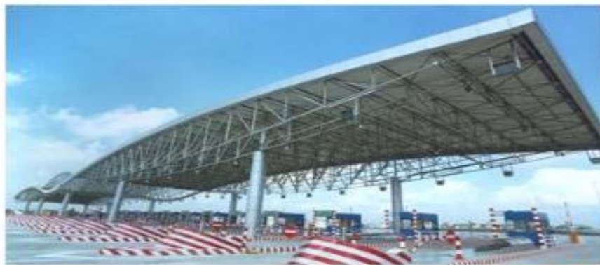
江阴长江大桥 收费站
