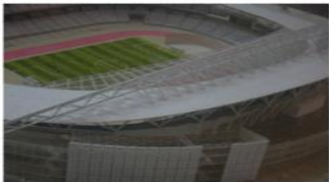
南京奥体馆 拱架式屋盖
