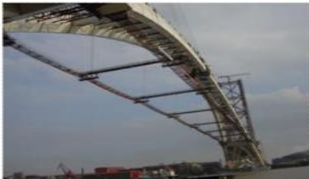
卢浦大桥梁式拱桥
