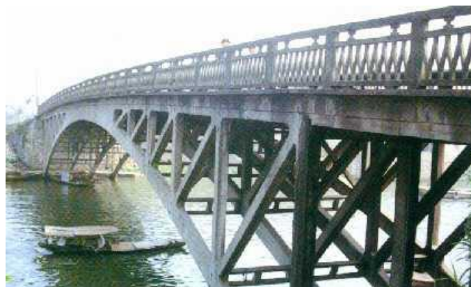
1971浙江余杭50米里仁桥
