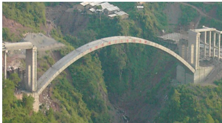
多箱浇筑成板拱与桥台形成 无铰拱
