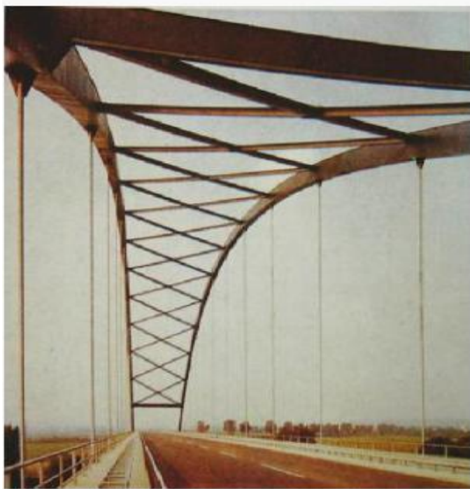
钢管混凝土拱肋的x横撑
