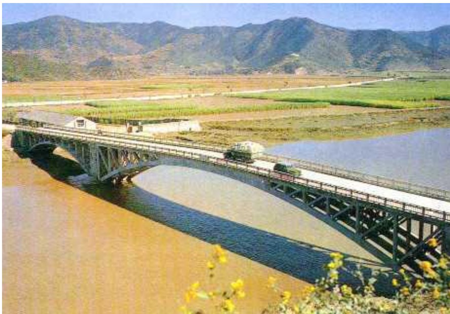
1976浙江宁海75米越溪桥
