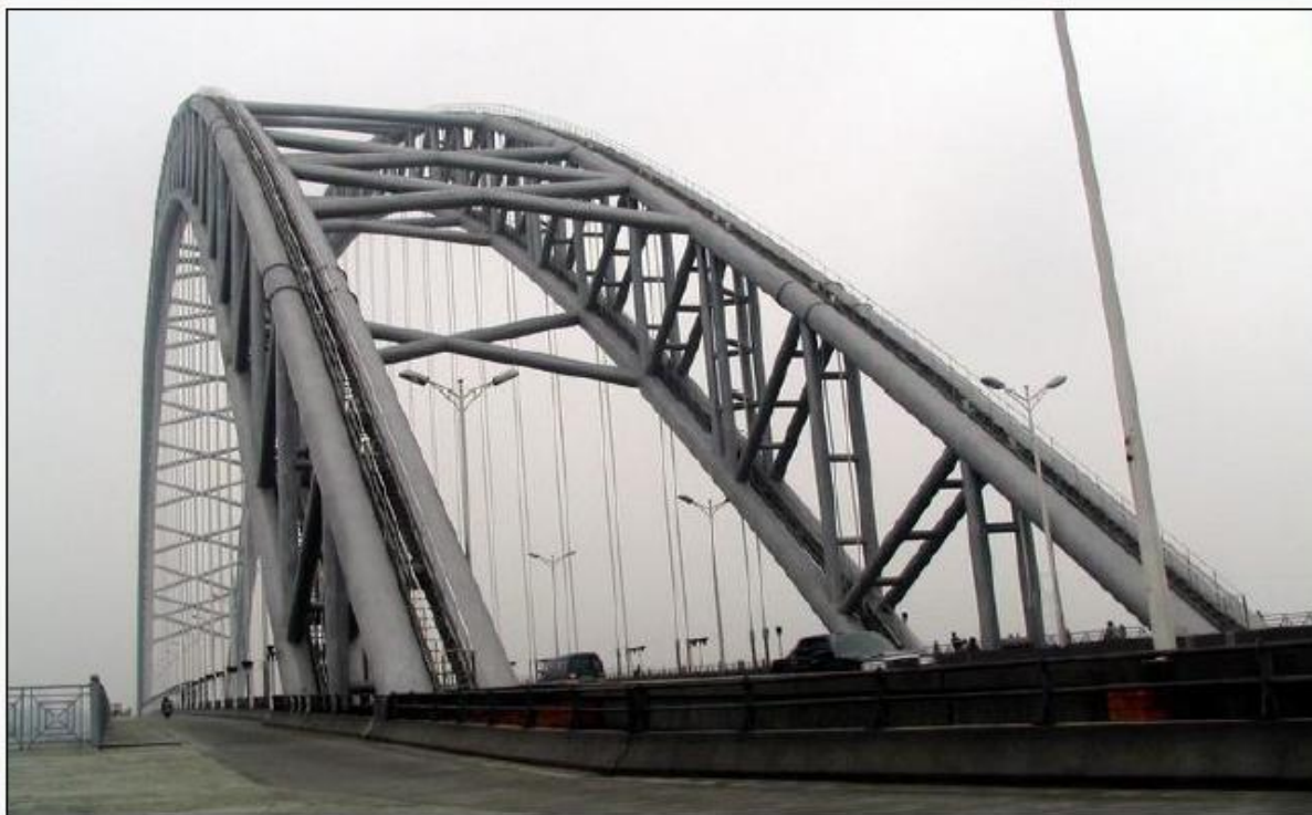
钢管混凝土拱肋的双层x横撑（南宁永和大桥）
