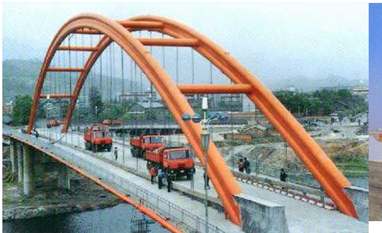
1990四川雅安大马河单肋钢管混凝土系杆拱桥，中跨矢跨比1/5，拱脚推力1.8万kN
