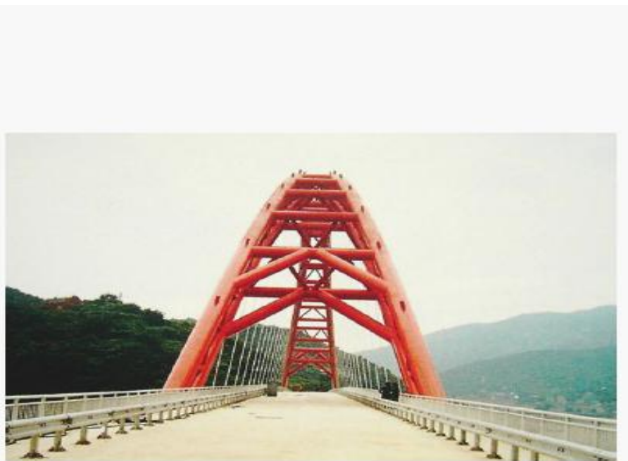
桁式K撑（浙江铜瓦门大桥）
