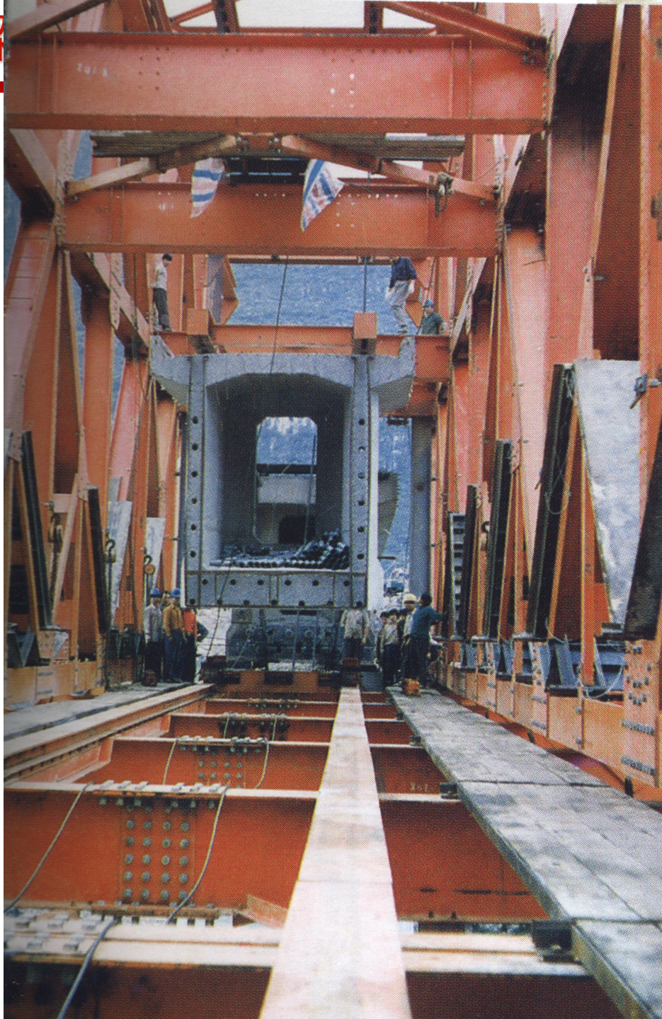
梁段在造桥机 内运送
