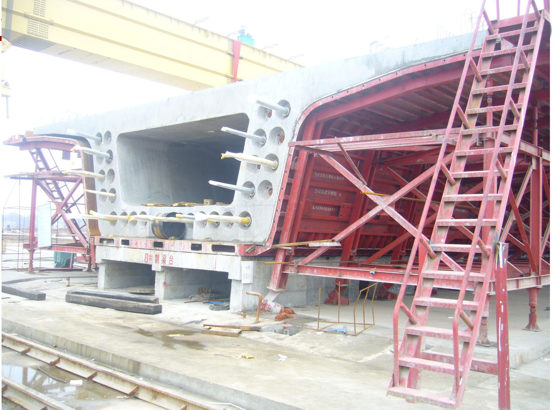
客专预应力混凝土简支箱梁端部
