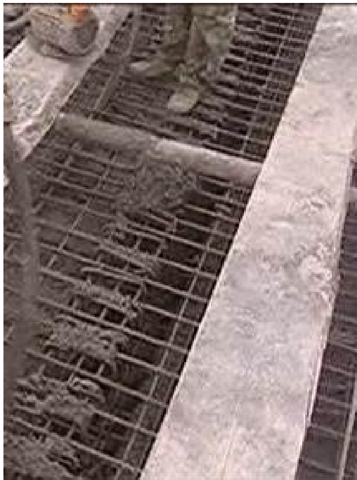
浇筑混凝土
