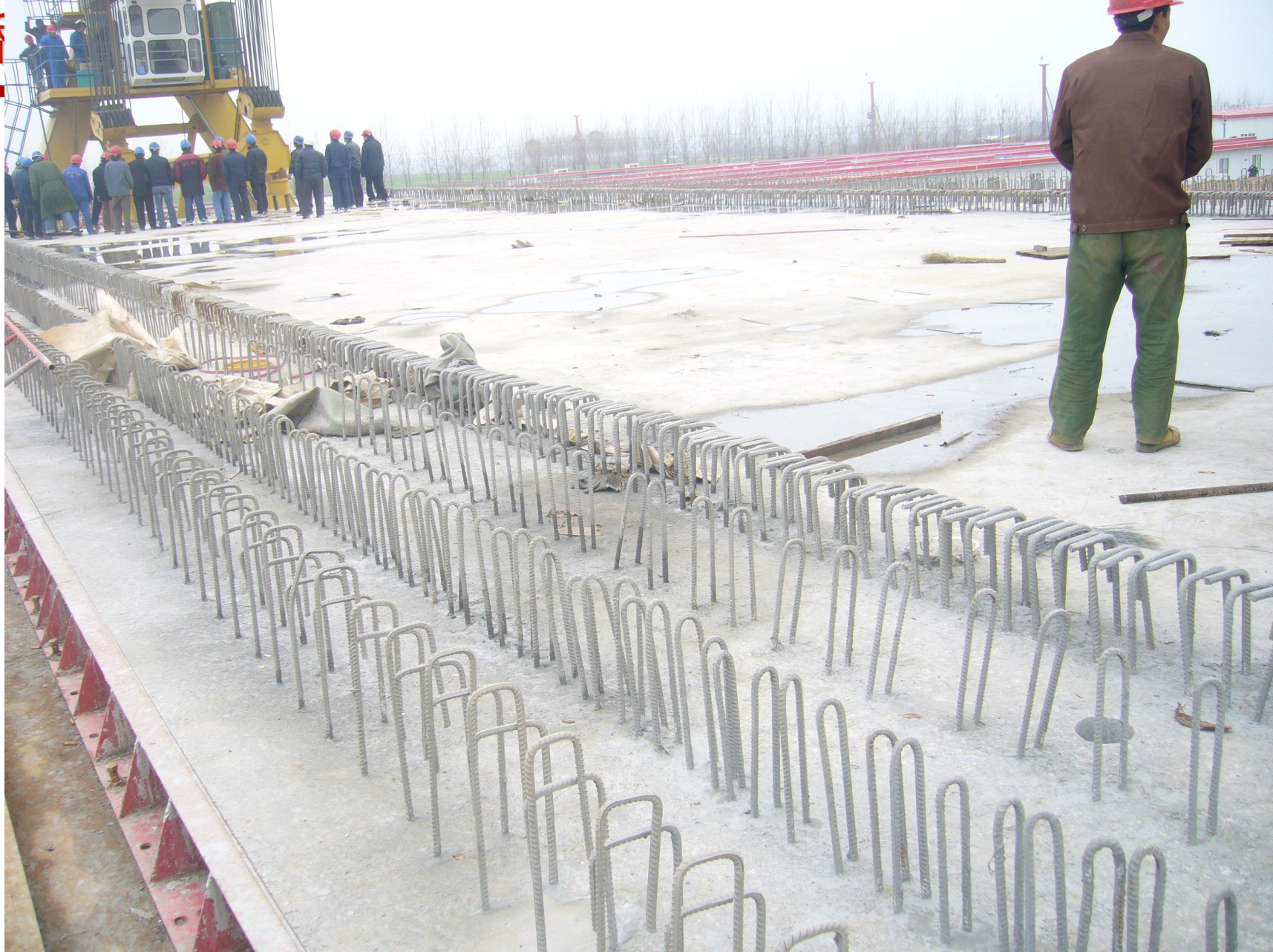
客专预应力混凝土简支箱梁顶部
