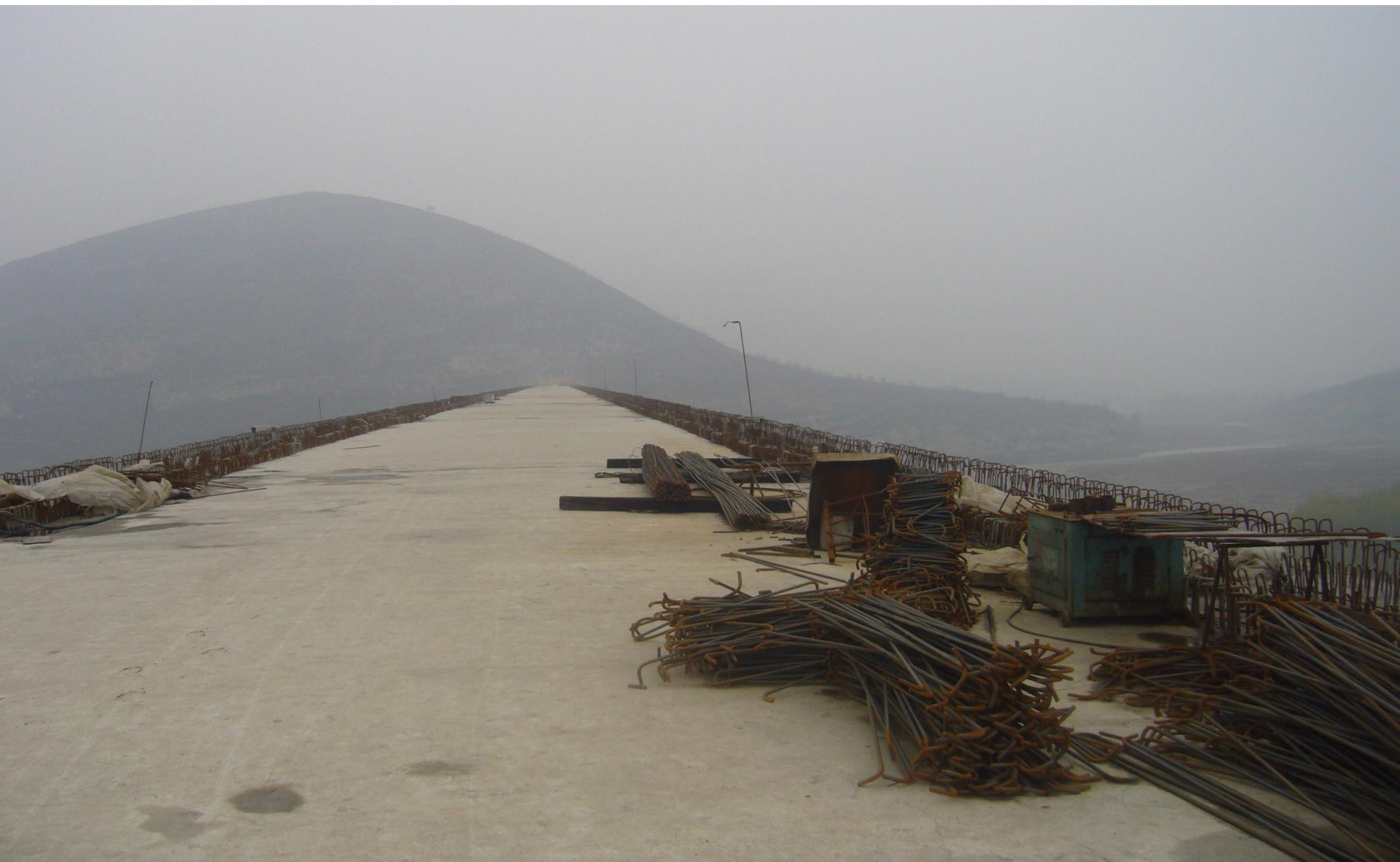
高速铁路有碴桥面箱梁上面情况
