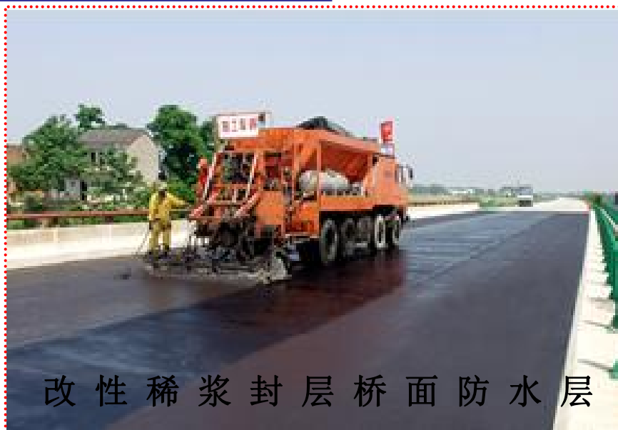
高速公路桥面的涂料养护
