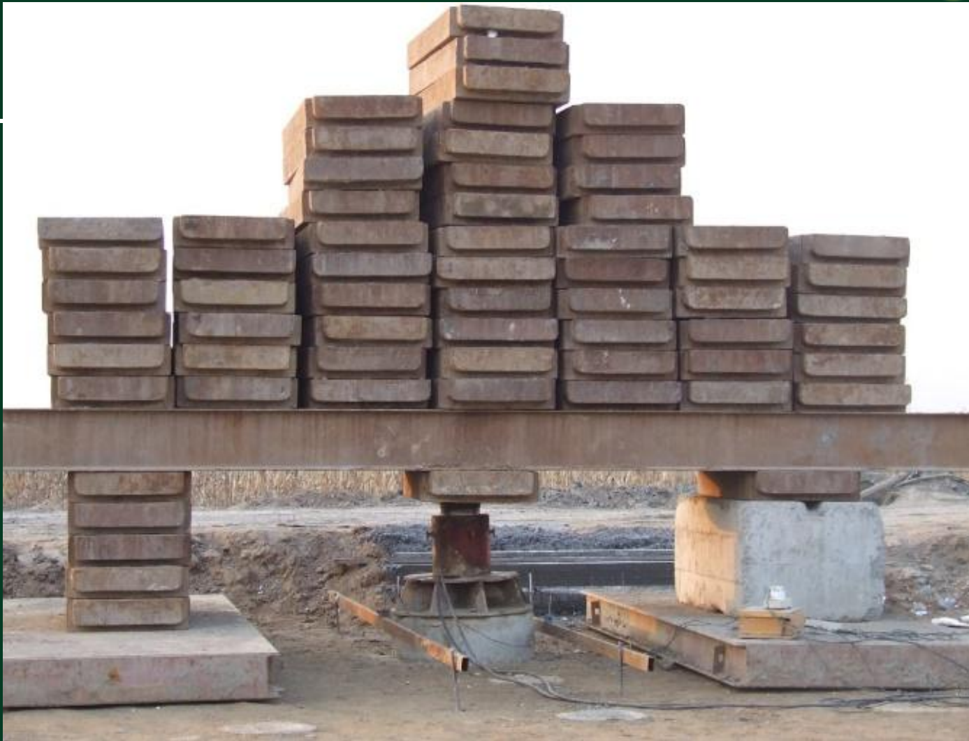
单桩静载试验实例图
