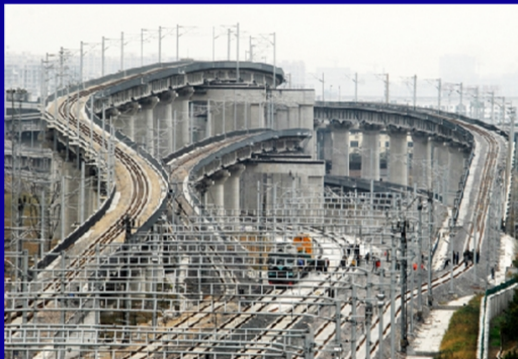
工人在京沪高铁上海虹桥站的工地施工
