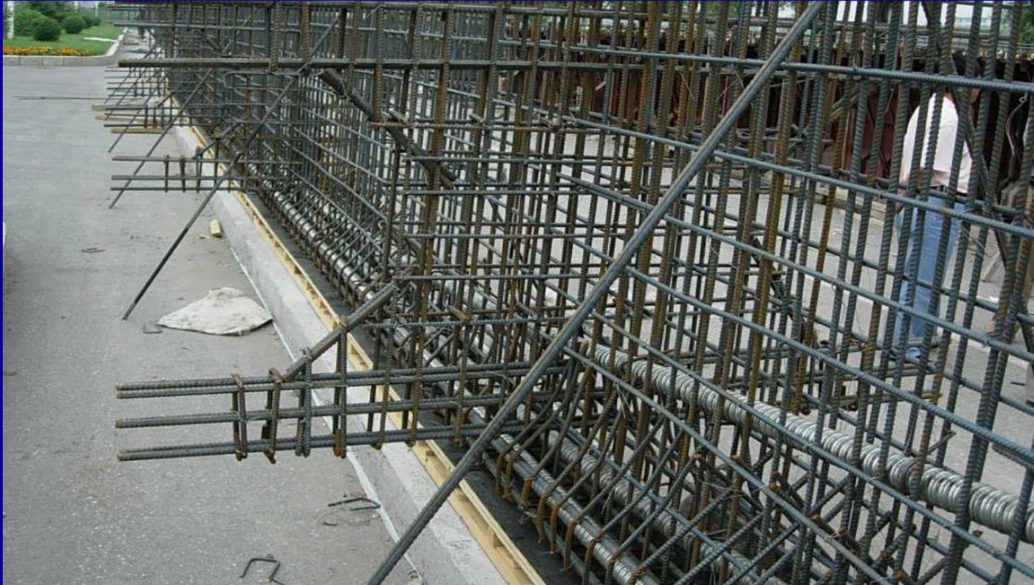
后张法梁体内预留的预应力管道
