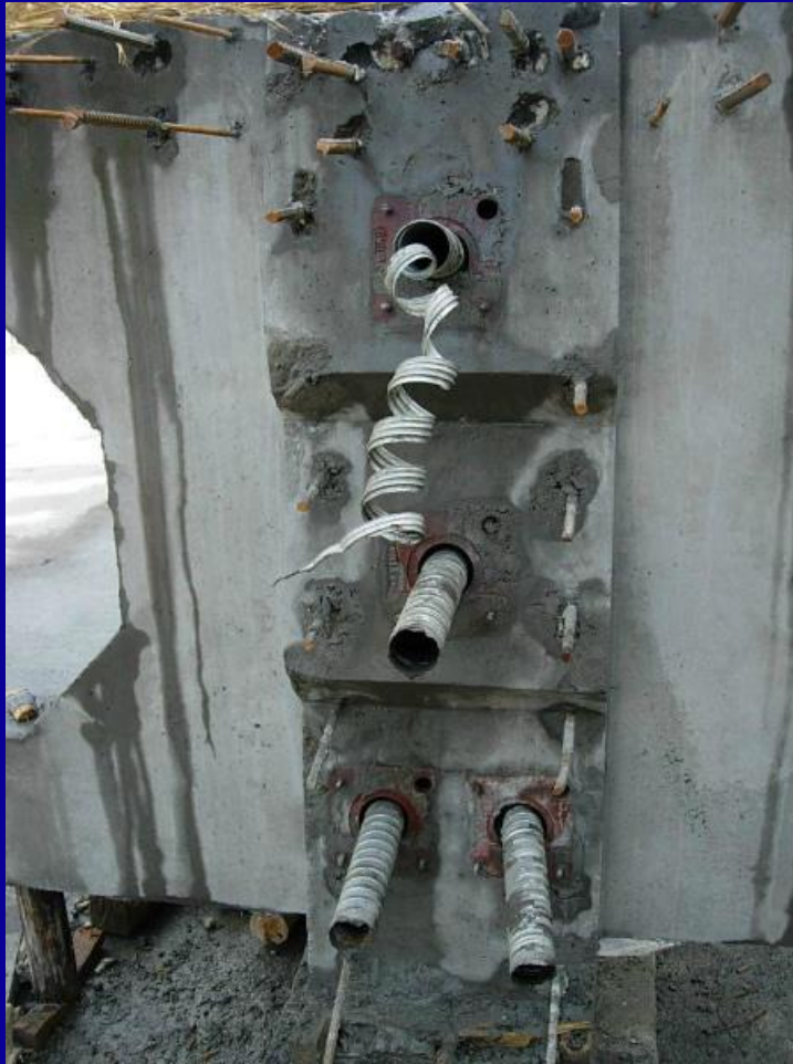
后张法中的锚垫板和波纹管道
