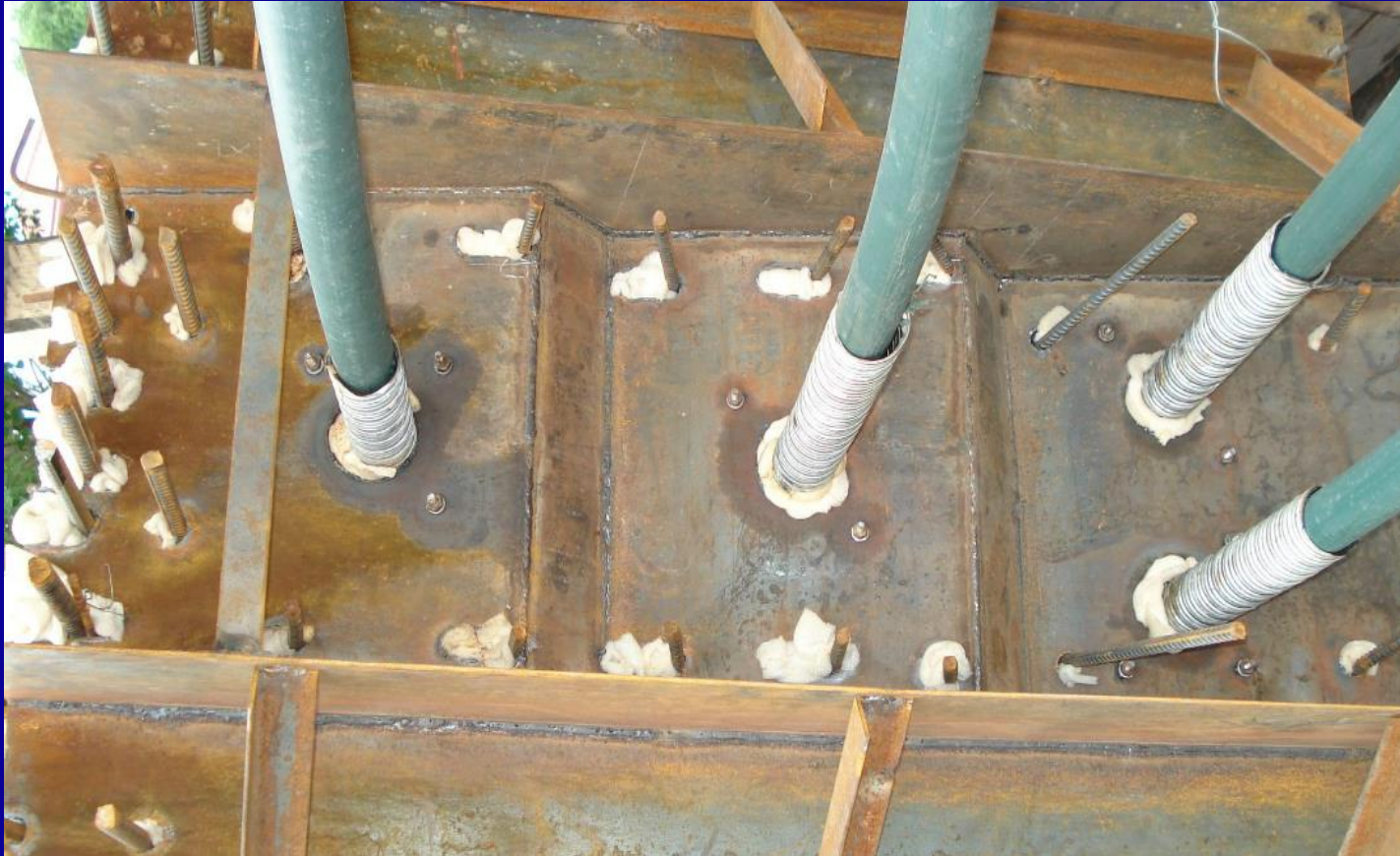
铁皮波纹管的芯管
