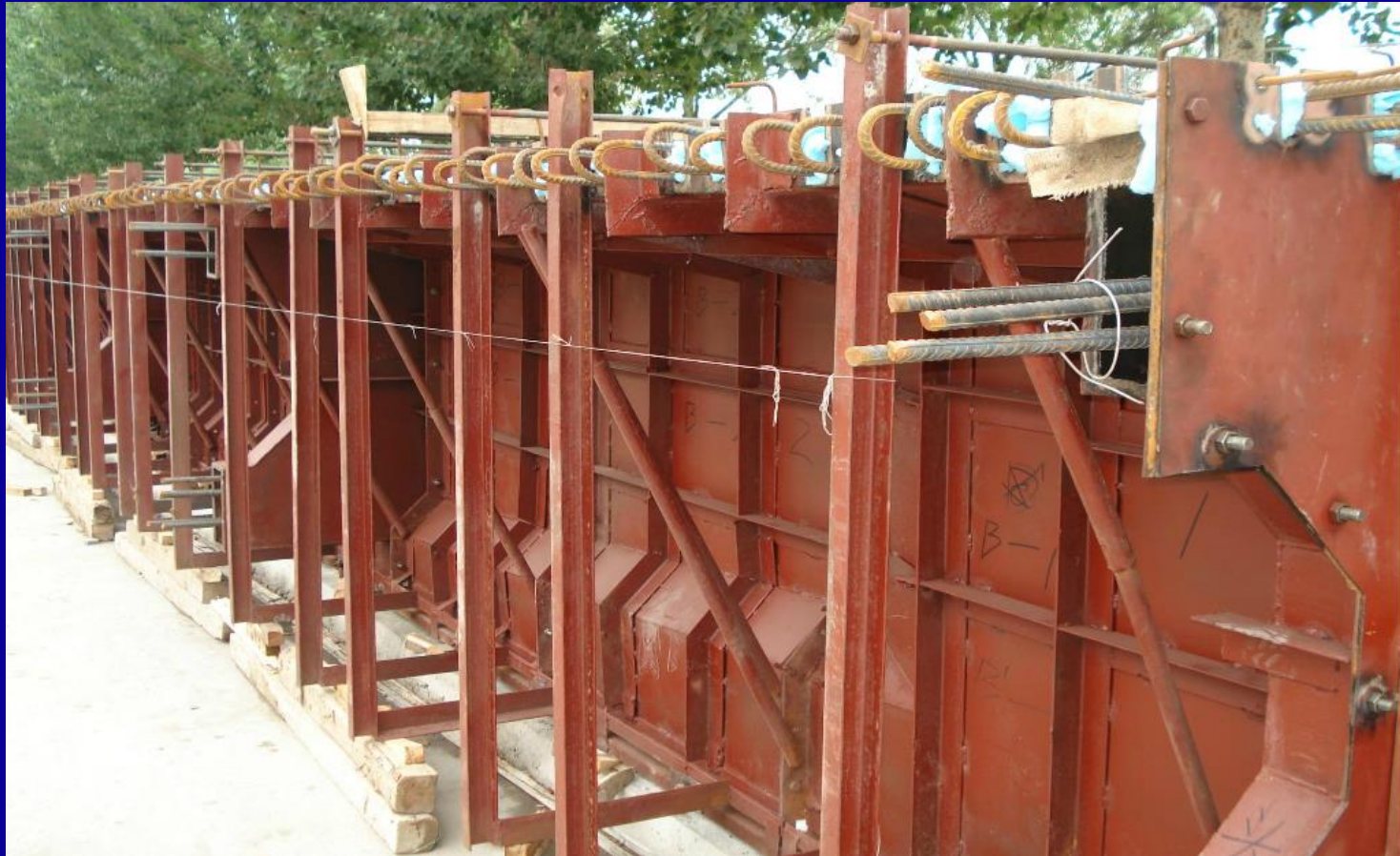
预应力混凝土T梁支座的钢模板
