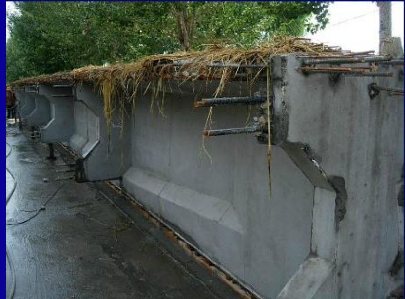
预制后的预应力混凝土T梁
