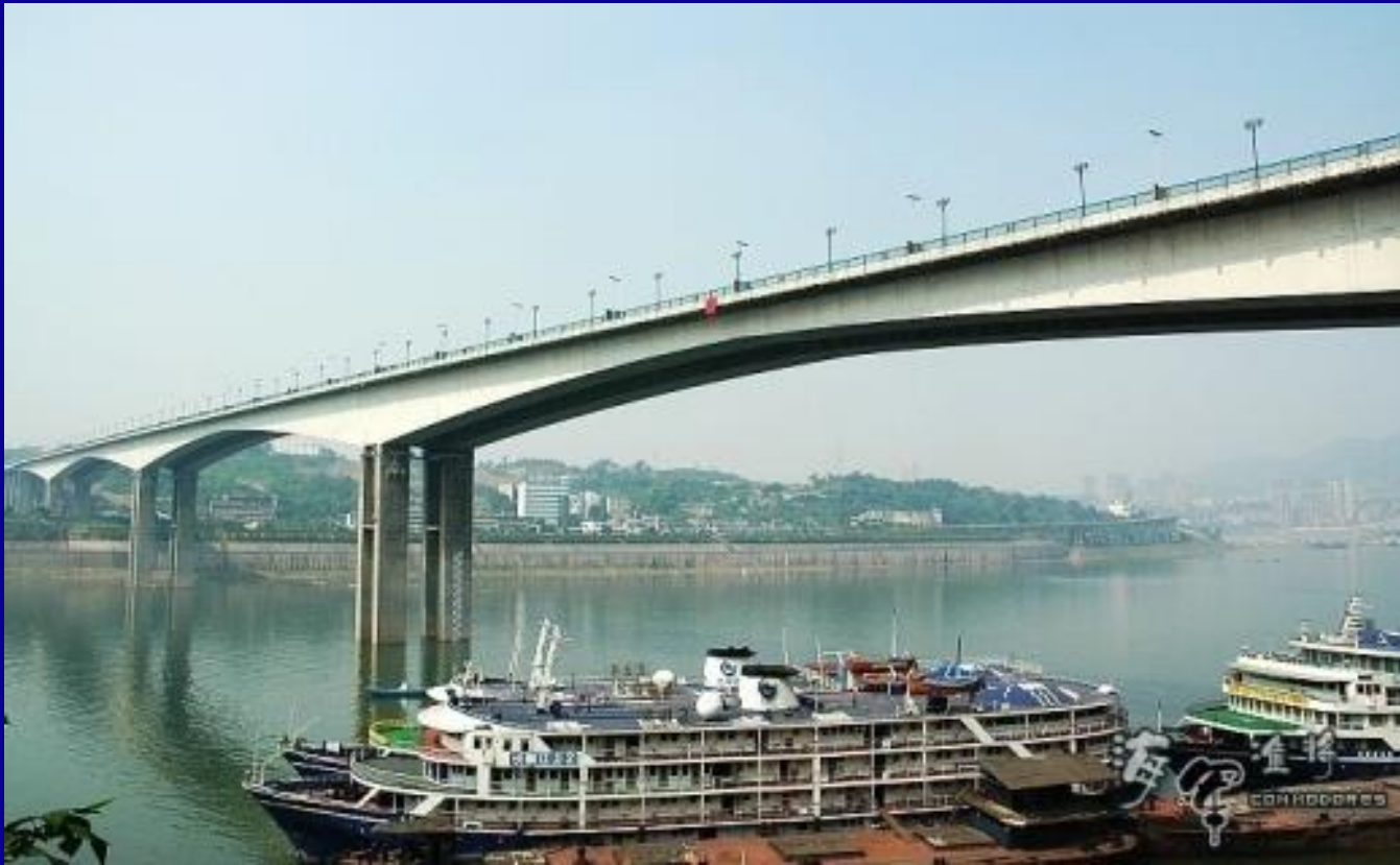
重庆长江大桥复线桥，最大跨径330m，钢-砼组合连续刚构，2006
