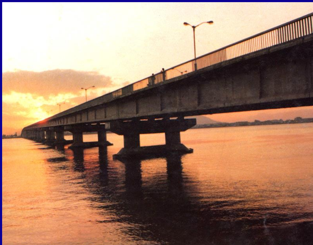
浙江飞云江桥，跨径62m，1988，中国最大跨度的预应力混凝土简支梁桥
